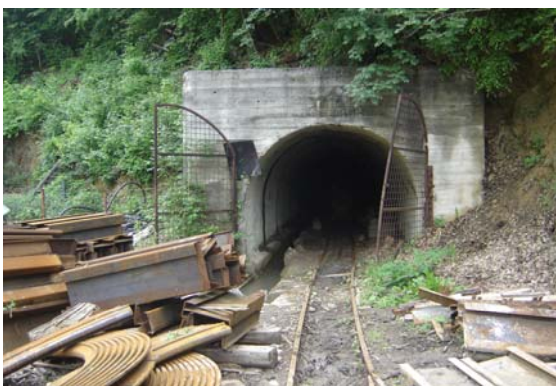
Slika 91. Ulaz u glavni izvozni potkop (GIP) jame „Jasenovac“ (foto B.Miladinović)
