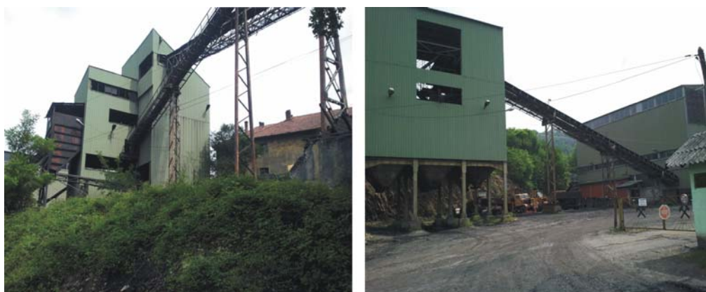
Slika 256. Separacijsko postrojenje uglja rudnika antracita „Vrška Čuka“ (sl. levo) zgrada separacije; (sl. desno) bunker za skladištenje opranog uglja (foto B.Miladinović)
