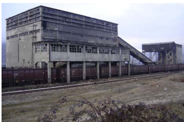
Slika 262. Postrojenje za „mokru“ separaciju uglja ibarskih rudnika u Piskanji-Baljevac (foto B.Miladinović)
