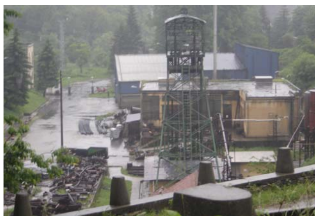
Slika 147. Servisno okno u Senjskom Rudniku (foto B.Miladinović)
