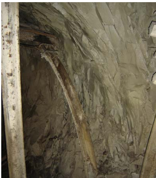
Slika 177. Suva rudarska prostorija OH-790 izrađena na k.790 kroz laporce u rudniku "Štavalj" (foto B.Miladinović)
