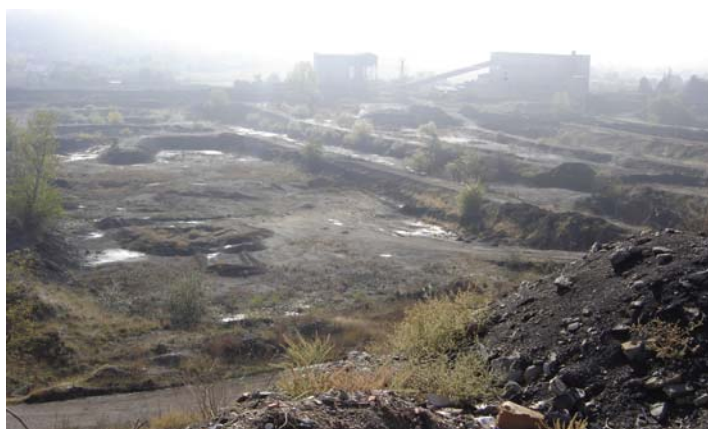
Slika 266. Bazeni za taloženje otpadnog mulja iz separacijskog postrojenja u Piskanji-ibarski rudnici (foto B.Miladinović)
