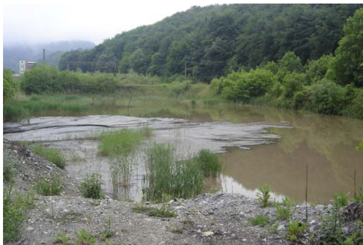
Slika 264. Bazen za taloženje mulja iz otpadnih voda separacije uglja u Resavici (foto B.Miladinović)
