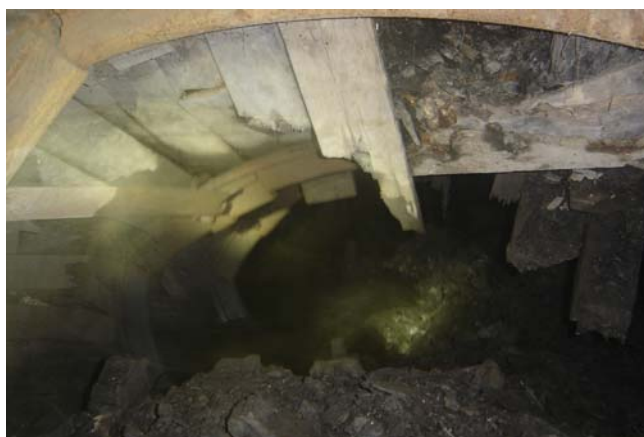
Slika 108. Deformacije krovine u potopljenoj rudarskoj prostoriji ON-1 rudnika „Lubnica“- Osojno jug (foto B.Miladinović)
