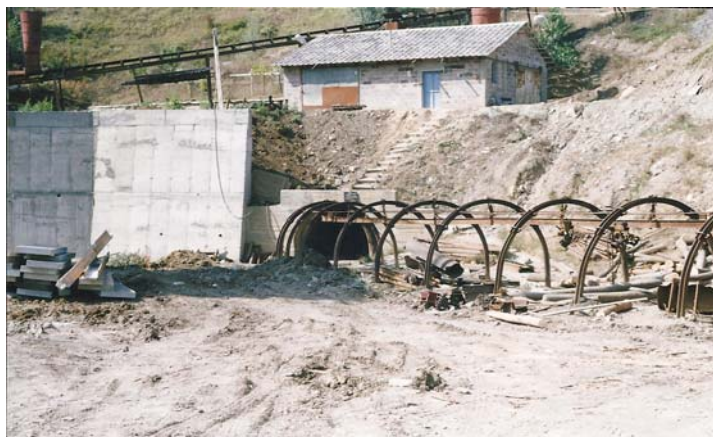
Slika 132. Ulaz u potkop ležišta uglja "Tadenje" (foto B.Miladinović)
