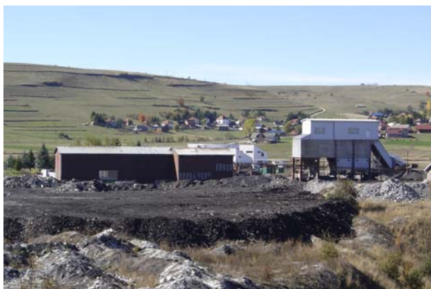
Slika 261. Postrojenje za separaciju uglja rudnika „Štavalj“ (foto B.Miladinović) (zgrada levo: „mokra“ separacija uglja; zgrada desno: „suva“ separacija uglja)
