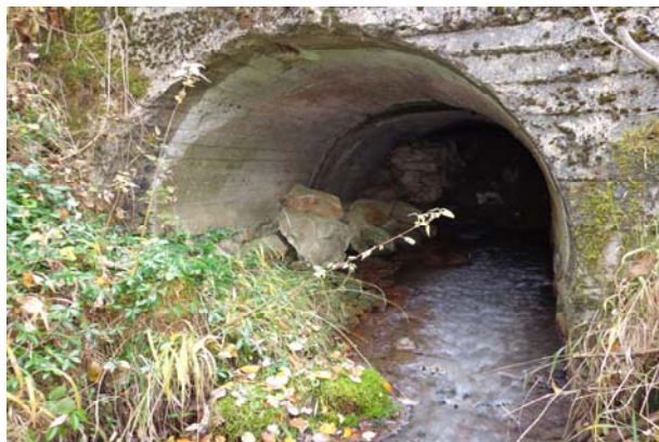
Slika 250. Isticanje rudničkih voda iz zatvorenog rudnika „Jerma“ potkop „Koznik“ (foto B.Miladinović)
