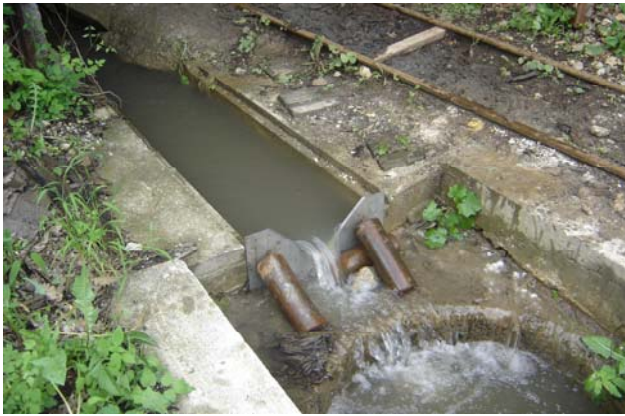
Slika 237. Mesto isticanja rudničkih voda iz potkopa GIP jame rudnika „Jasenovac“ (foto B.Miladinović)
