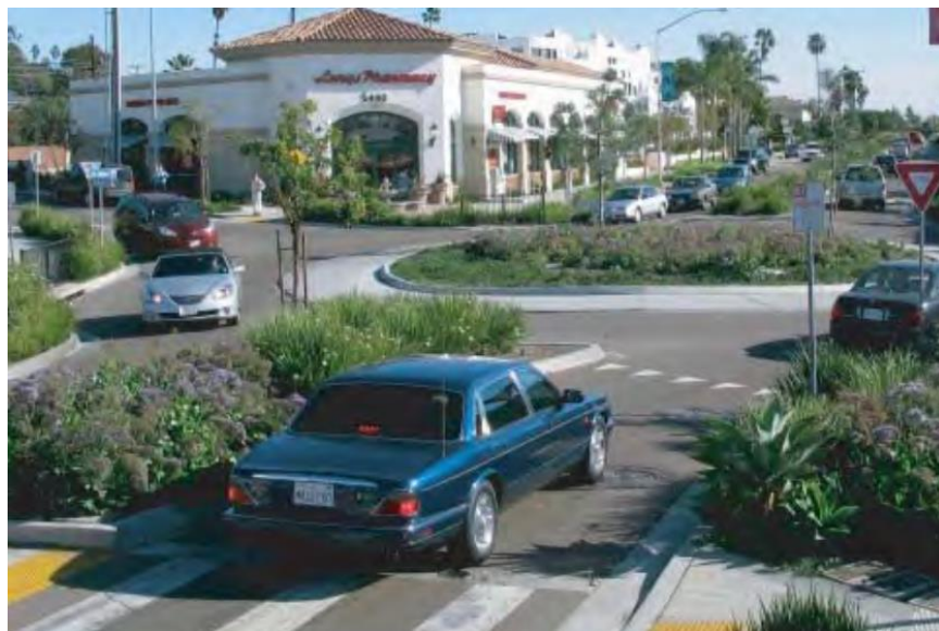
Слика 3.22 Пример кружне раскрснице у Сан Дијегу на којој ниско растиње на разделном острву омета прегледност (Rodegerdts et al., 2010)
