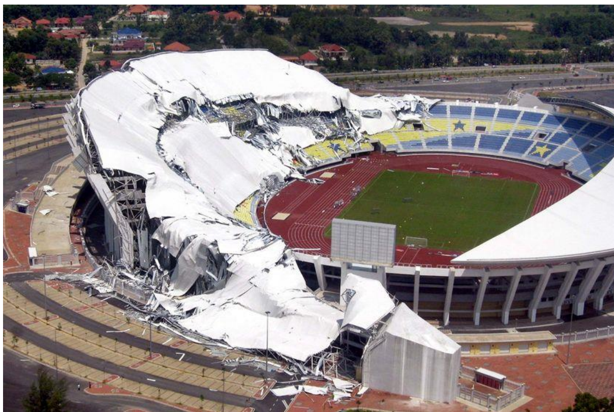
Slika 3.4. Kolaps krova stadiona Sultan Mizan Zainal Abidin u Kuala Terengganu, Malezija [24].
