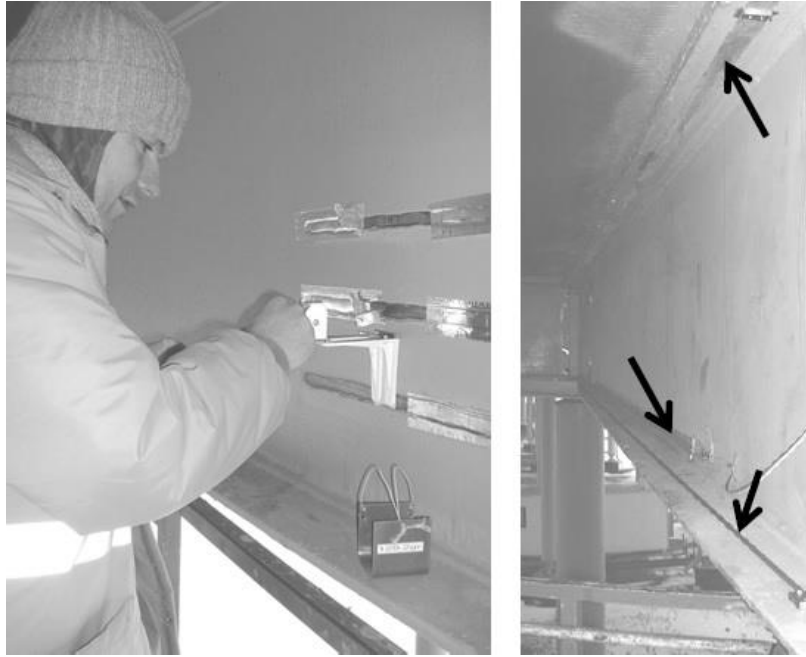
Slika 8.10. Testiranje lepljenja SMARTape senzora na terenu (levo) i instaliran SMARTape senzor za finalno testiranje [252].
