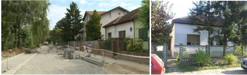
Slika 162. i Slika 163. Jednoporodične kuće u ulici Antona Čehova još imaju duh prethodnog naselja
