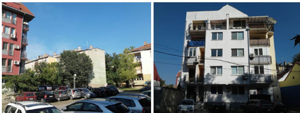
Slika 283. i Slika 284. Započeto pogušćavanje već postojećeg višeporodičnog stanovanja u Zrenjaninu
