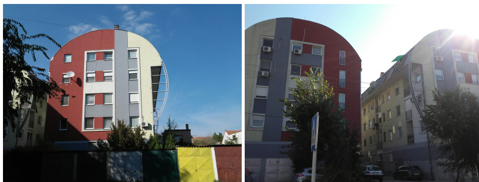
Slika 285. i Slika 286. Nizovi novih višeporodičnih objekata u Zrenjaninu u okviru porodičnog stanovanja
