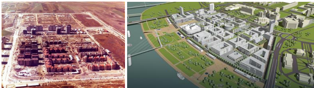
Slika 84. Novo Naselje u Novom Sadu u izgradnji
