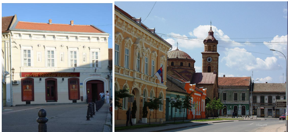
Slika 290. i Slika 291. Kulturno graditeljsko nasleđe Vršca - Sterijina rodna kuća (slika levo) i objekti u centru (slika desno)
