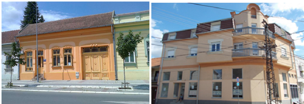
Slika 298. i Slika 299. Renovirana stara jednoporodična kuća (slika levo) i novi višeporodični stambeni objekat (slika desno) u Vršcu
