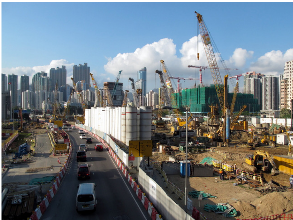
Slika 22. Konstantno postojanje gradilišta u velikim gradovima i periferijama, Kina
