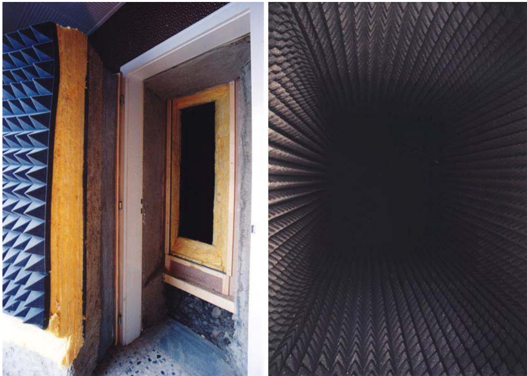
Slika 8: Kuća u r: ulazak u Potpuno izolovan mrtav prostor (levo) i pogled u prostoriju (desno)
