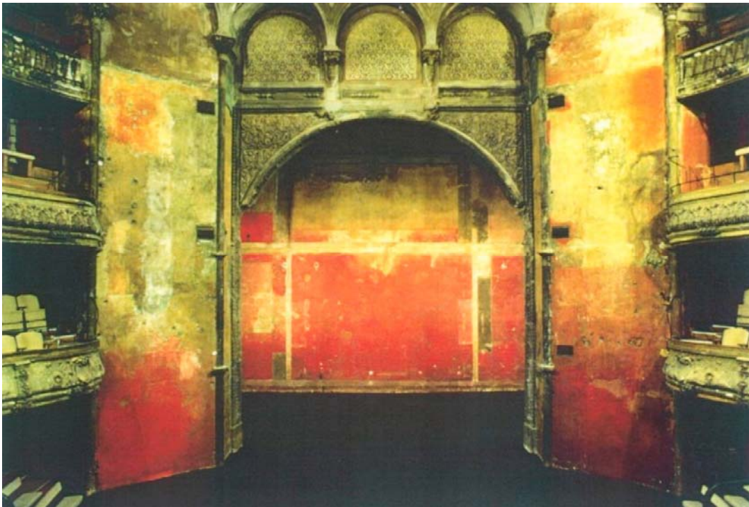
Slika 15: Enterijer pozorišta „Le Theatre des Bouffes du Nord“, nakon rekonstrukcije
