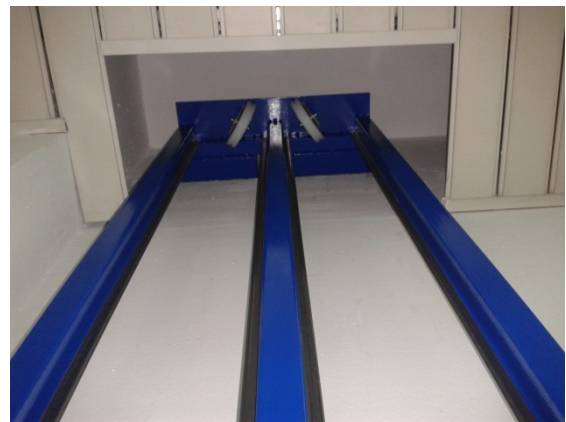
Слика 45. Горњи дио лифта са вођицама и помоћним ужницама.
