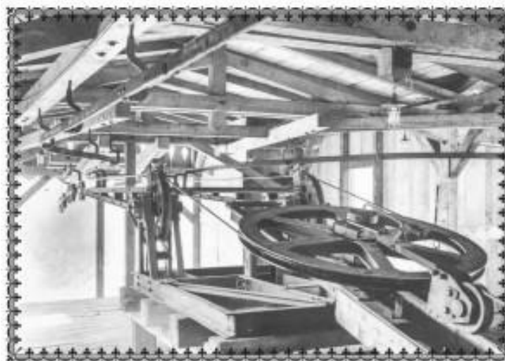
▲ Lijevo krilo zgrade stanice saustima naponski (vučni) uređaj za I sekciju
