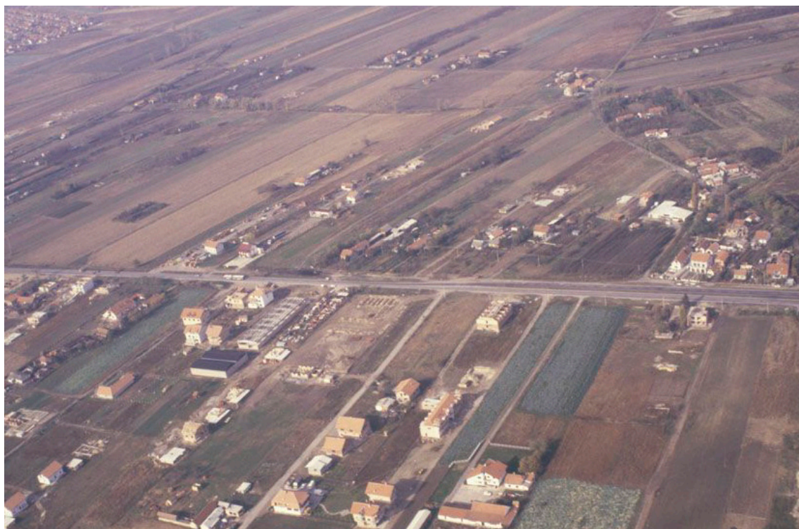
Sl. 58 Futoški put i okolina 1995. godine. U gornjem delu slike je područje Veterničke rampe, u to vreme još uvek slabo izgrađeno.
