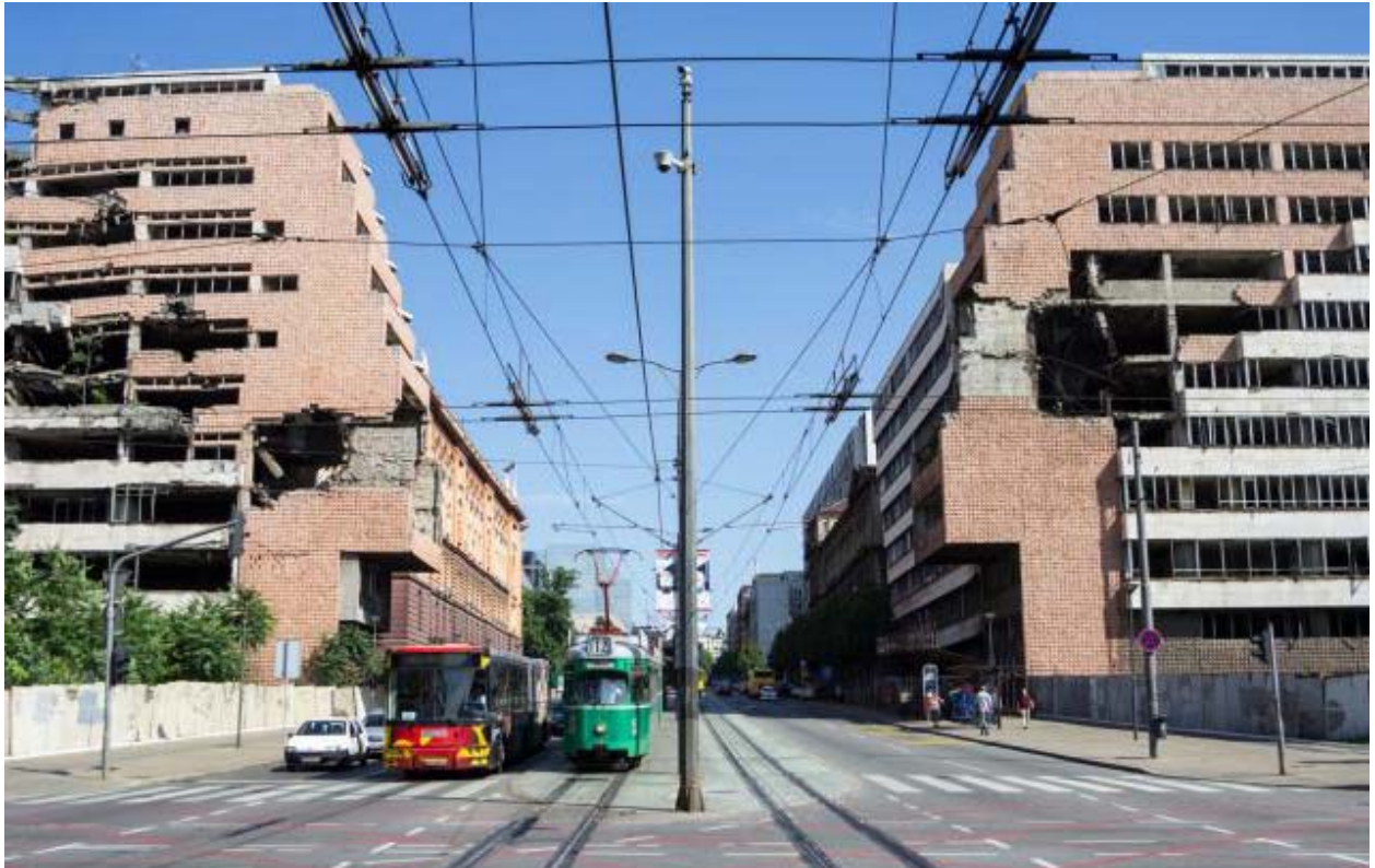
Generalštab, Zgrade A i B nakon NATO bombardovanja 1990. godine, Beograd, 2015.
