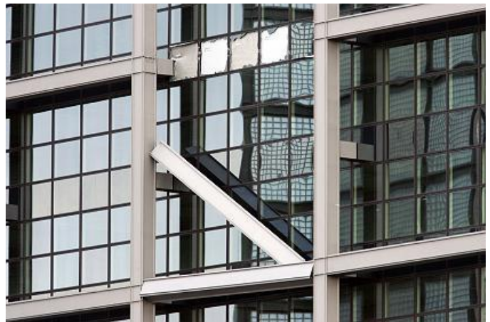
Slika 4.14. Oštećenje noseće konstrukcije fasadnog zida glavne železničke stanice, Berlin http://www.spiegel.de/fotostrecke/photo-gallery-berlin-s-train-station-damaged-in-storm-fotostrecke-18720.html
