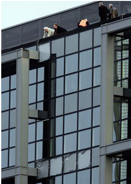
Slika 4.14. Oštećenje noseće konstrukcije fasadnog zida glavne železničke stanice, Berlin http://www.spiegel.de/fotostrecke/photo-gallery-berlin-s-train-station-damaged-in-storm-fotostrecke-18720.html
