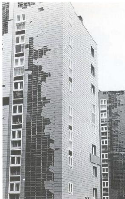
Slika 4.15 Oštećenje fasadnih zidova (Hoffer 2008)
