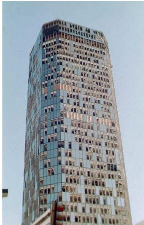
Slika 4.12. Oštećenje fasade Bank One Tower, Teksas (Smith 2000) http://www.aawe.org/gallery/display.php?i=68&p=&c=
