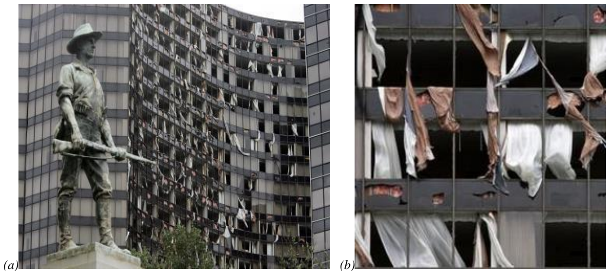
Slika 4.12. Oštećenje fasade Bank One Tower, Teksas (Smith 2000) http://www.aawe.org/gallery/display.php?i=68&p=&c=
