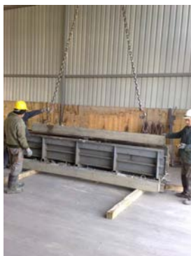
Слика 4.9 Вађење изливених гредних носача из калупа
