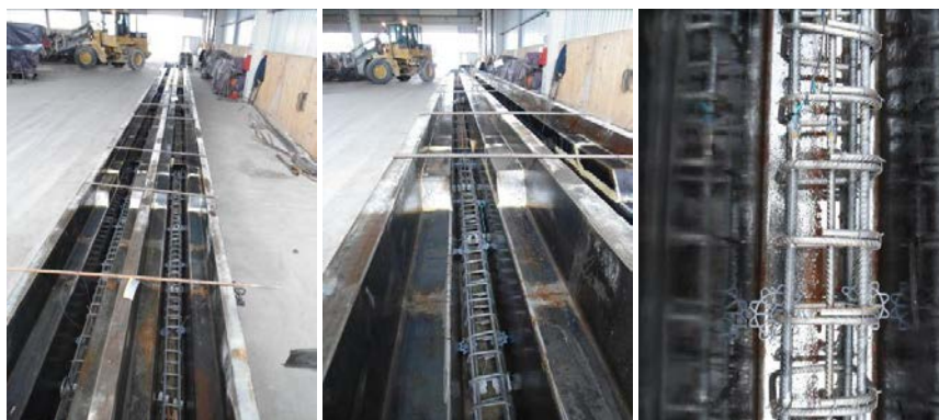
Слика 4.7 Арматурни склопови са постављеним дистанцерима и уграђеним мерним тракама пред уградњу бетона
