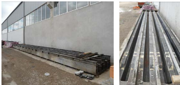
Слика 4.2 Припрема оплате – калупа
