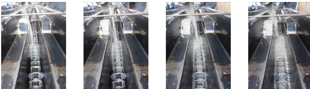
Слика 4.8 Процес уградње бетона (SCC R 100)
