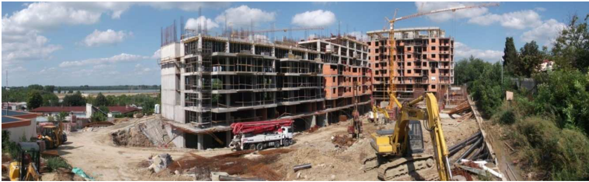
Slika 7. – Mešoviti armiranobetonski konstruktivni sistem u praksi
