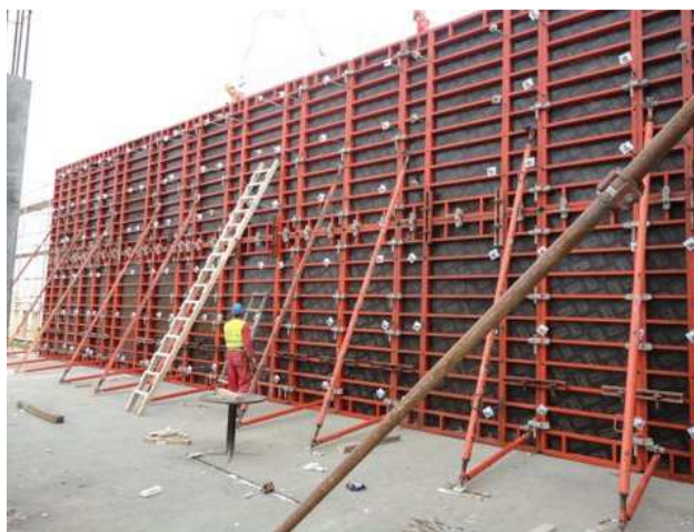
Slika 9. – TRIO oplata za jednovremeno betoniranje zida debljine 20cm, visine 6,50m i dužine 30m
