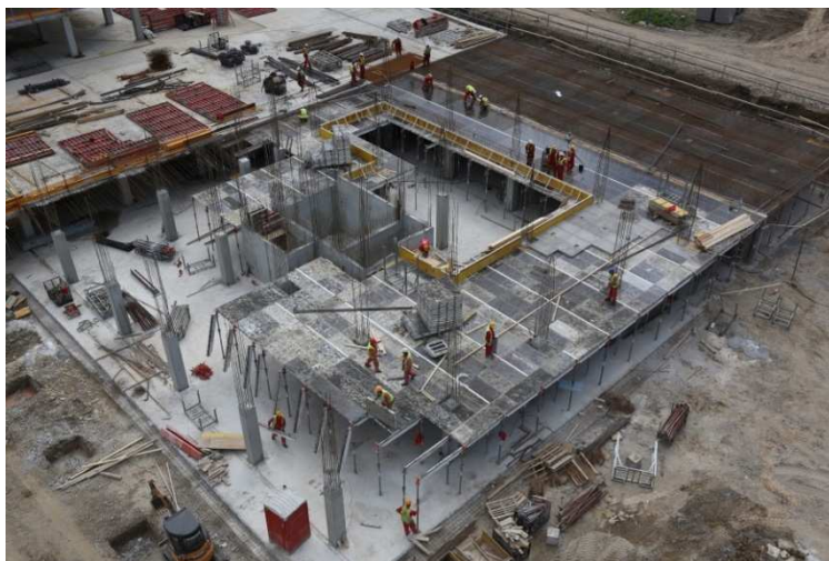
Slika 15. – SKYDECK montaža na gradilištu
