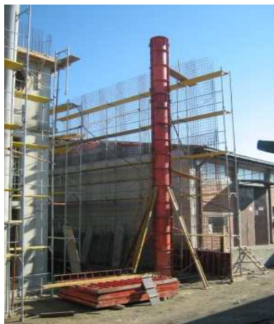
Slika 14. – SRS kružna oplata za betoniranje stuba prečnika 60cm i visine 12m
