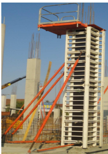
Slika 13. – RAPID sistem stubova u praksi
