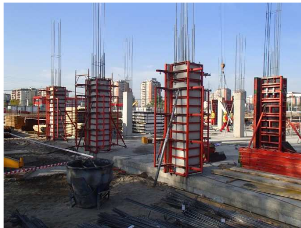
Slika 11. – QUATTRO sistem stubova u praksi
