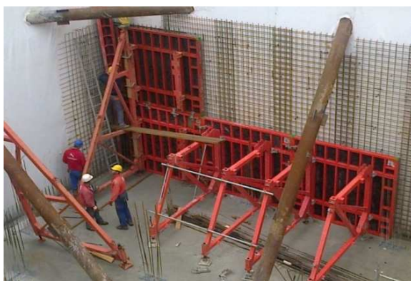
Slika 10. – DOMINO oplata za betoniranje jednostavnog zida debljine 20cm za zaštitu temeljne jame
