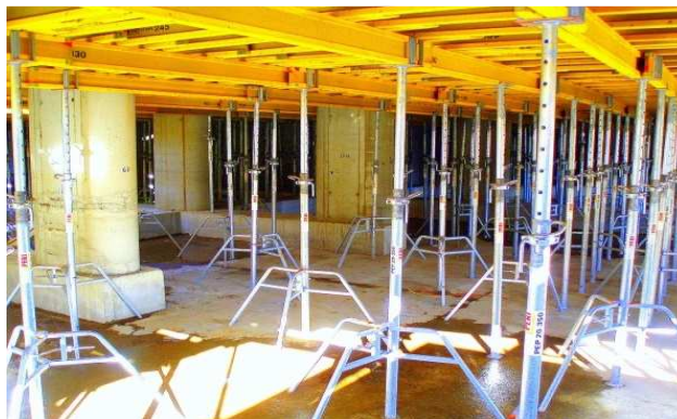
Slika 18. – MULTIFLEX sistem sa primarnim i sekundarnim punim drvenim nosačima VT20 i podupiračima sa tronošcem
