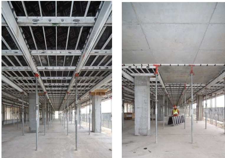
Slika 17. – SKYDECK demontaža panela i pomoćno podupiranje statičkim setom
