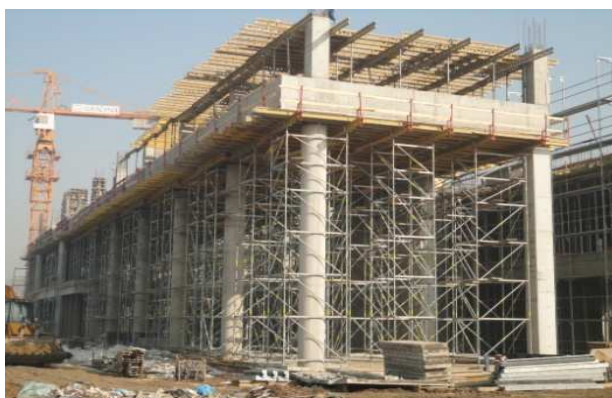
Slika 19. – UP ROSET tornjevi za podupiranje
