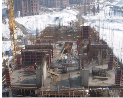
Slika 4. – Masivni poprečni armiranobetonski konstruktivni sistem u praksi
