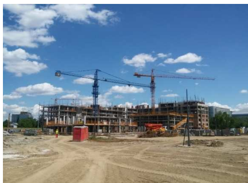
Slika 6. – Skeletni armiranobetonski konstruktivni sistem u praksi
