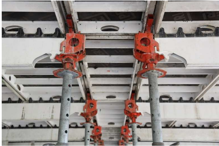
Slika 16. – SKYDECK podupiranje sa padajućim glavama
