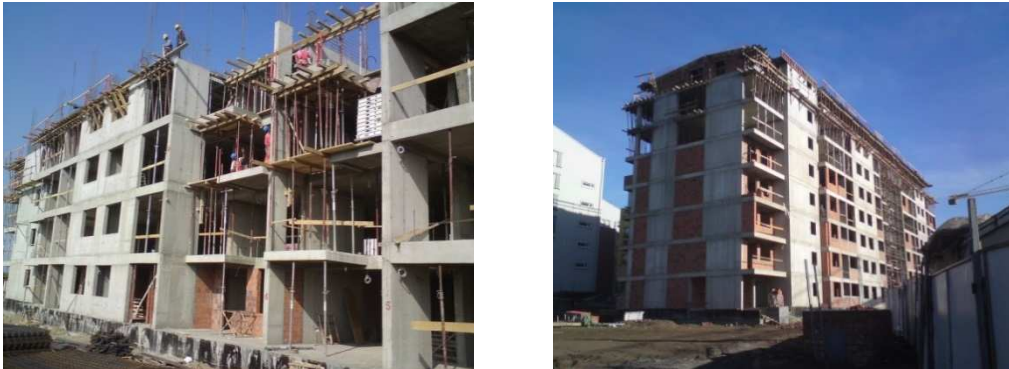
Slika 2. – Masivni podužni armiranobetonski konstruktivni sistem u praksi
