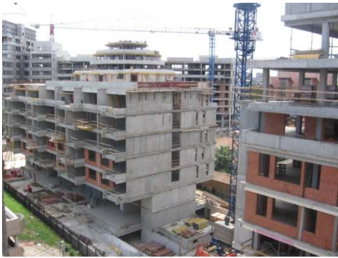
Slika 4. – Masivni poprečni armiranobetonski konstruktivni sistem u praksi
