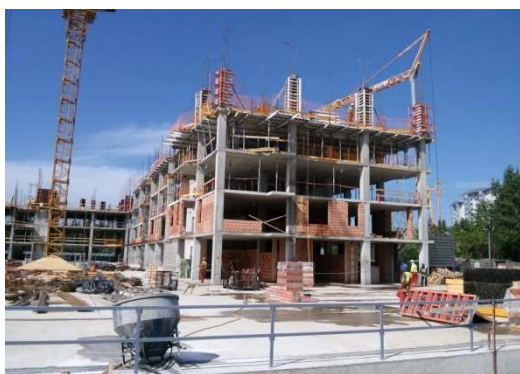
Slika 6. – Skeletni armiranobetonski konstruktivni sistem u praksi
