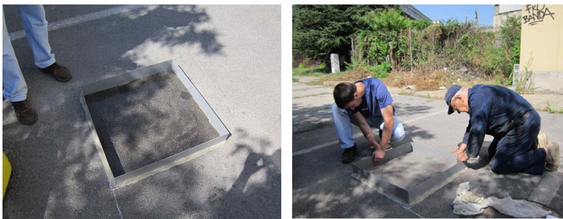
Slika 3-6. Postavljanje rama na asfaltnu podlogu
