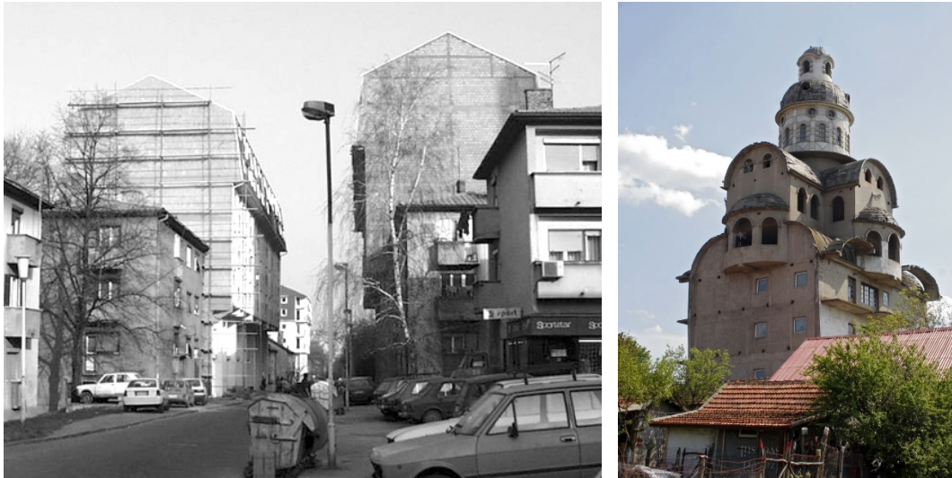
Sl. 55 – Beogradska bespravna gradnja: Karaburma 2001. godine – stambene zgrade proširene u gabaritu, dograđeni spratovi, ne uvažavajući kontekst, regulaciju, arhitekturu.
