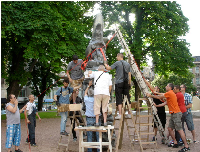
50. Монтажа , монтирање горњег дела стуба уз помоћ импровизованог чекрка
