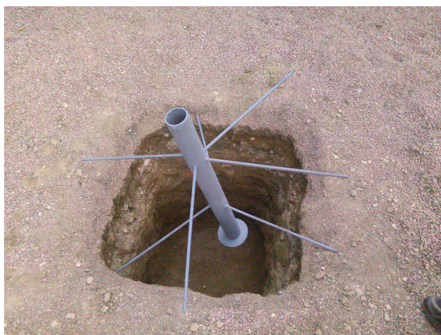
48. Цев која иде у темељ са арматуром
