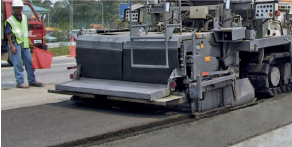
Slika 9 Ugrađivanje finišerom na recikleru sa inicijalnim zbijanjem sloja Hladne reciklaže na licu mesta. [17]
