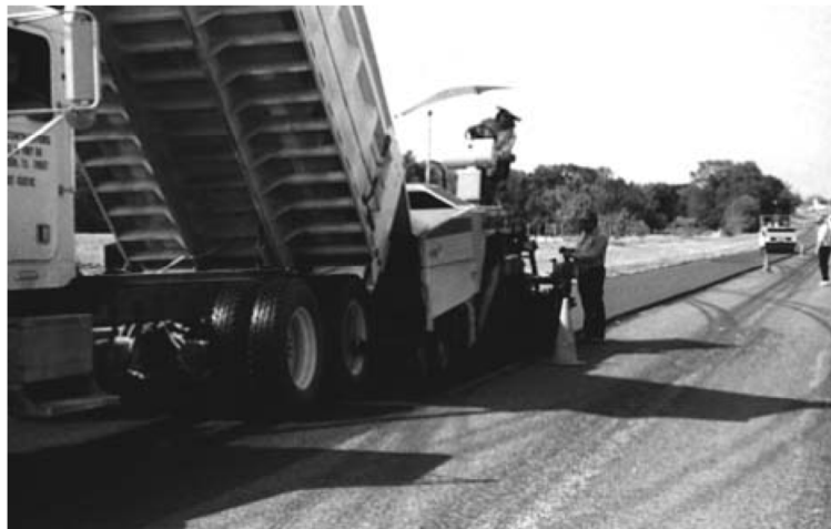
Slika 15 Ugrađivanje mešavine hladno reciklirane u centralnom postrojenju. [16]
