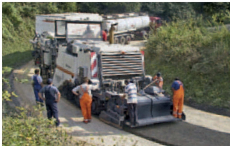
Slika 10 Wirtgen 2200 CR recikler sa finišerom za ugradnju i inicijalno zbijanje. [17]
