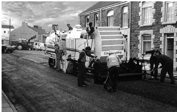
Slika 6 Jednodelni voz za hladno recikliranje na licu mesta. [16]
