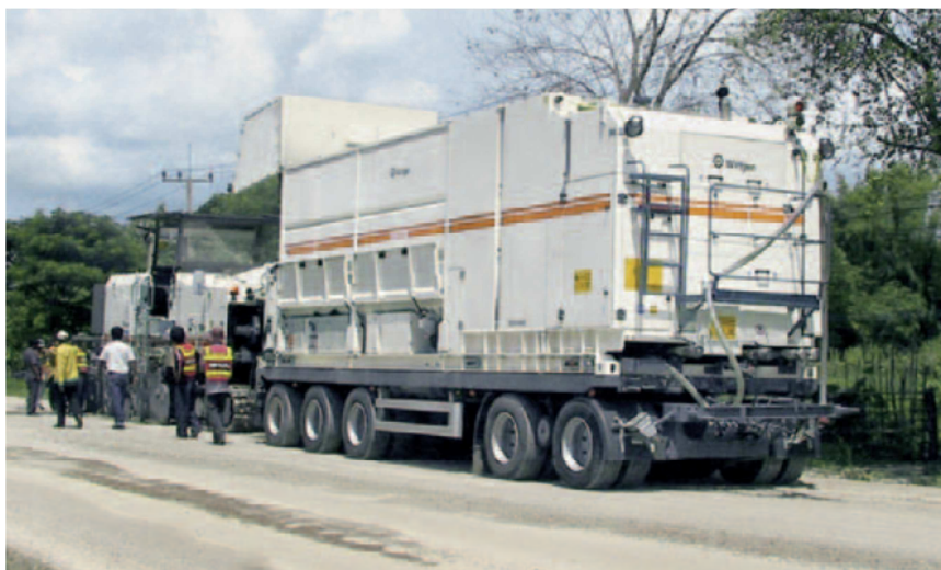
Slika 3 Doziranje cementa kao vodene suspenzije sa Wirtgen WM1000. [17]
