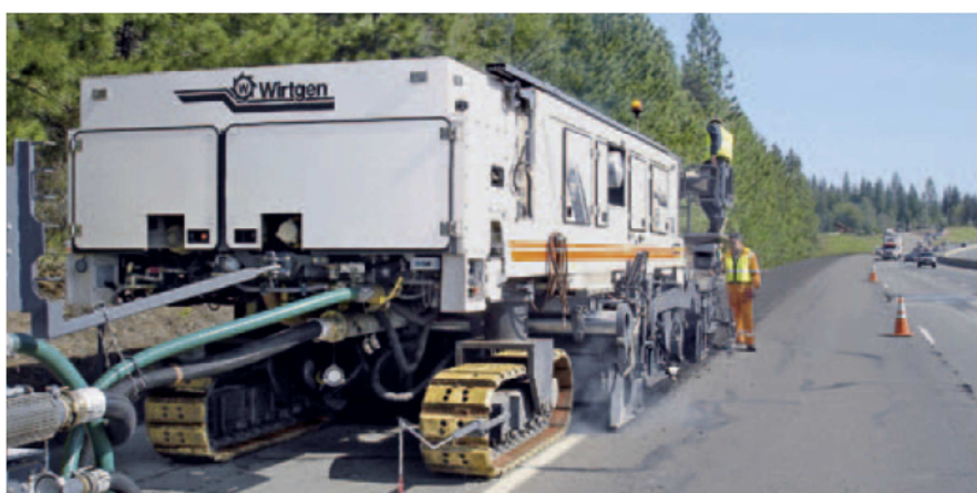
Slika 11 Wirtgen 4200 CR recikler sa finišerom za ugradnju i inicijalno zbijanje vrši recikliranje trake autoputa od 4.2m širine u jednom prolazu. [17]
