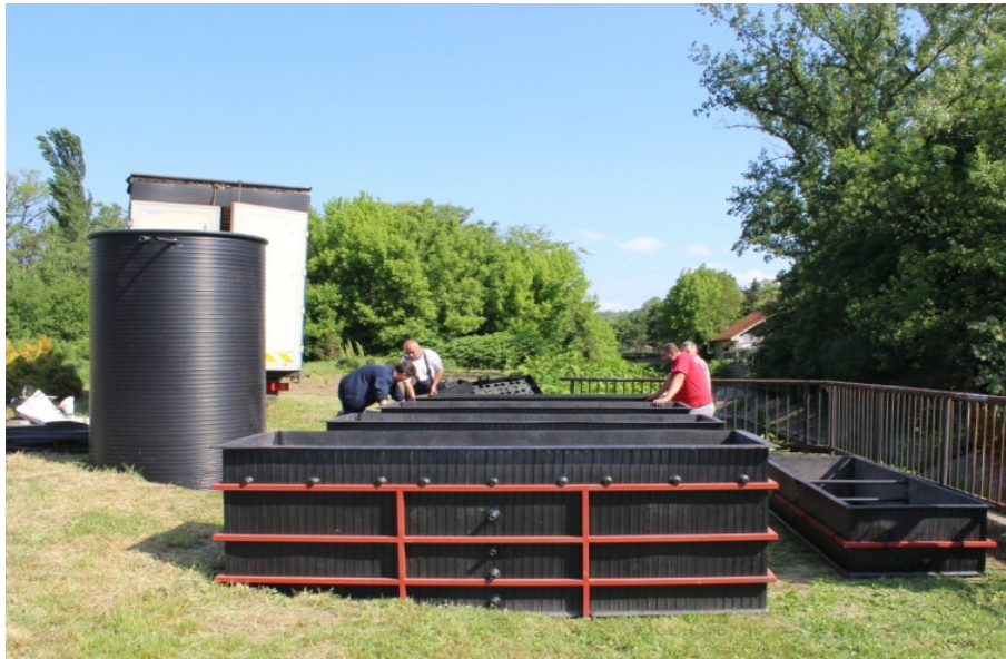
Slika 20. Izgled biološkog sistema
