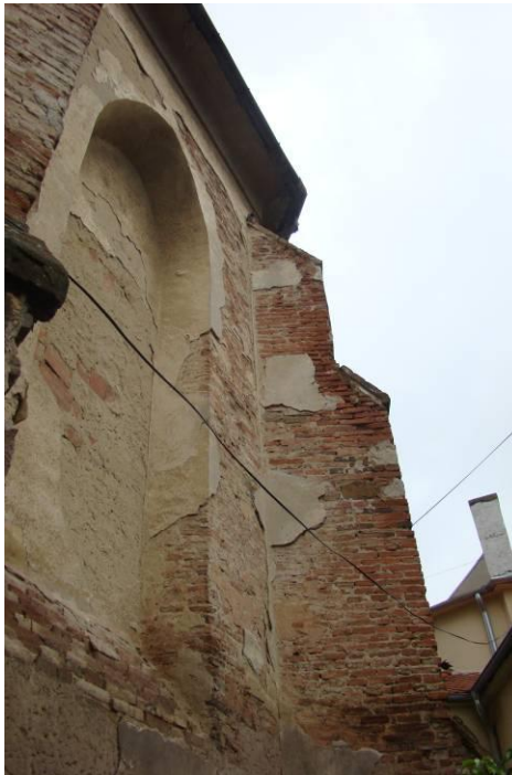
73. РКЦ Пресветог Тројства у Сремским Карловцима (1728) – на фасадном зиду светишта су видни елементи претходне грађевине инкорпорирани у стурктуру новог објекта – високи прозор надившен преломљеним луком и контрафори на угловима полигоналног зида олтарске апсиде.
