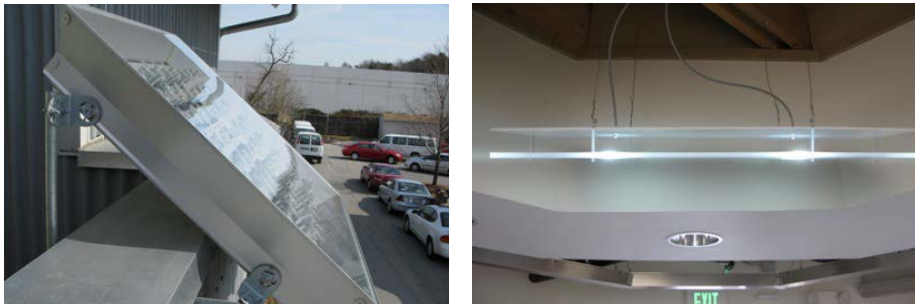
Слика А27. Примјер уграђеног система свјетловодног оптичког уређаја са спољашње стране, на фасади, слика лијево, и поглед из унутрашњости просторије, слика десно (доступно 10.03.2013. године на сајту http://www.huvco.com/portfolio_detail.php?id=12 )
