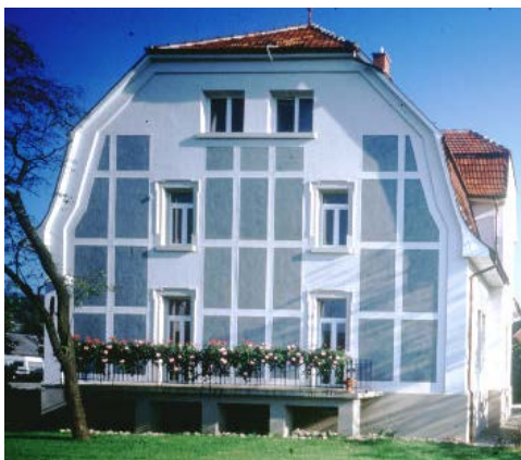
Слика 10. Примјер стамбене зграде у Фрајбургу, Њемачка, гдје је примјењен композитни систем и на слици је у сивим зонама фасаде. Дебљина од 10cm ТИ чини U коеф. =0,94W/m^2K (Voss, K. Results and Experience of International Demonstration Buildings on Solar Energy in Building Renovation, pp. 8., http://www-cenerg.ensmp.fr/ease/retrofit.pdf )
