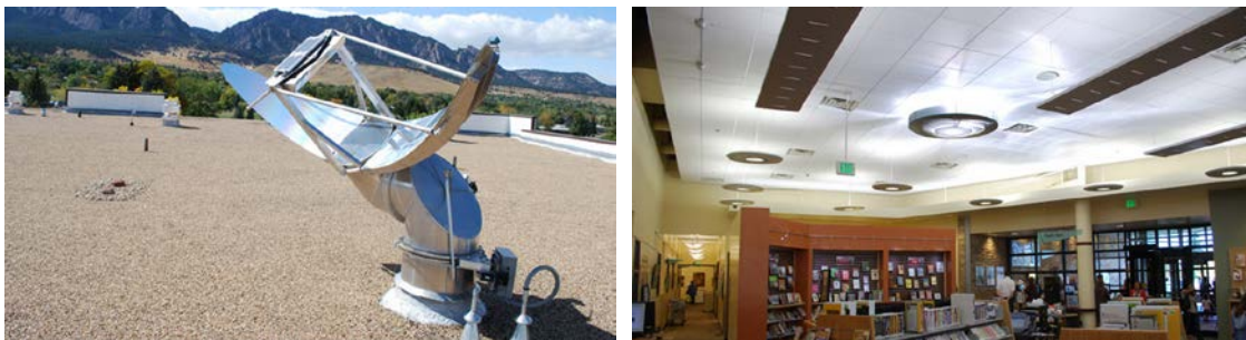
Слика А25. Примјер уграђеног вертикалног система са спољашње стране, на крову, слика лијево, и поглед из унутрашњости просторије, слика десно (доступно 10.03.2013. године на сајту http://www.eco-logic.info/pub/Sundolier )
