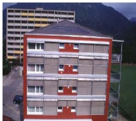
Слика 11. Примјер стаклене зид-завјесе са ТИ на постојећој стамбеној згради у Нидерунену, Швајцарска (Voss K., Results and Experience of International Demonstration Buildings on Solar Energy in Building Renovation, pp. 9., http://www-cenerg.ensmp.fr/ease/retrofit.pdf )
