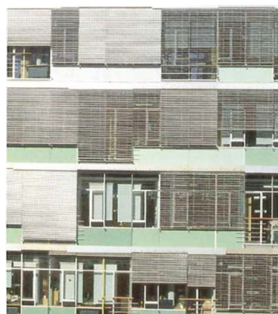
Слика А14. Примјер редуковања долазног сунчевог зрачења системом вањског засјенчења, која је процјењена на фактор умањења F_c = 0,25 , графички приказ - лијево, изглед зграде – десно (Hegger M., Fuchs M., Stark T., Zeumer M., Energy Manual: sustainable architecture , 2008., стр. 98)
