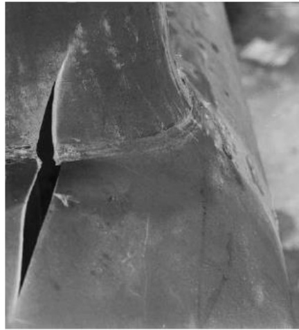
Slika 1.19. Prikaz pukotine nastale na spoju dva cilindra [33]
