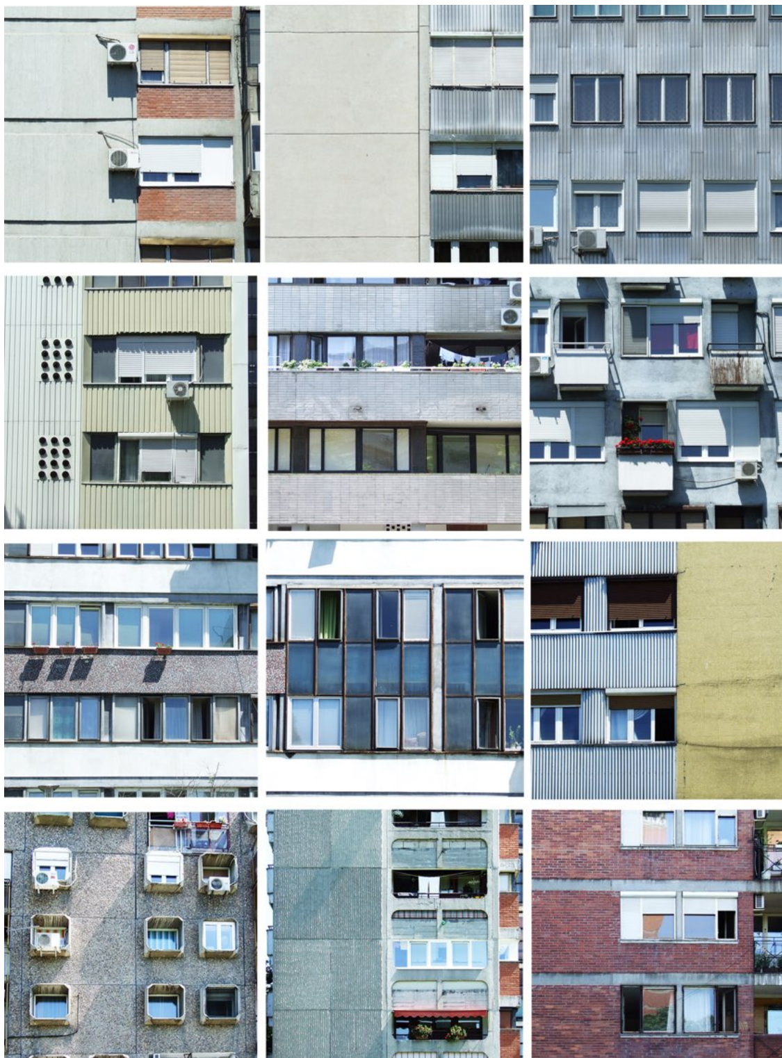
Слика 3-1 Фасаде стамбених зграда из 1960-их и 1970-их година - примери примене различитих материјала и фасадних обрада | Фото: Н. Мацут, (Stanković B. and Macut N. 2014)
