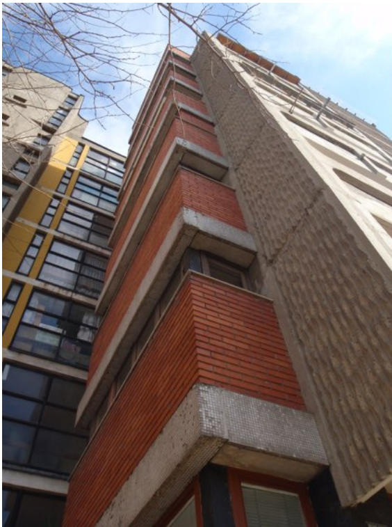
Слика 3-4. Бетонска платна на зградама новобеоградског блока 29 | Фото: Д. Игњатовић
