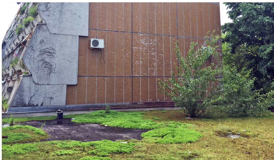
Слика 3-13. Самоникла вегетација на равном крову
