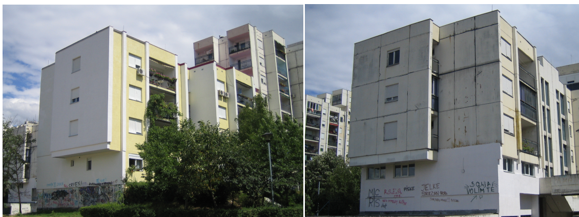
Слика 3-8 Део зграде на којој су станари сами санирали армиранобетонску префабриковану фасаду и суседна зграда са непромењеном фасадом
