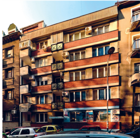
Слика 3-3. Примери стамбених зграда са армиранобетонским фасадним зидовима - представници типова Д6 (лево) и Е5 (десно) Националне типологије стамбених зграда Србије | Фото: С. Боснић
