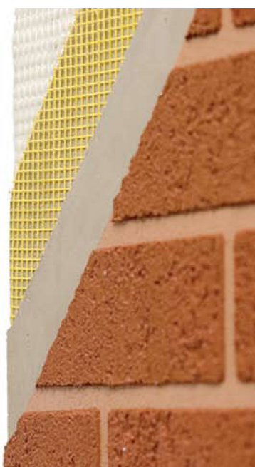
Слика 3-6. Систем контактне фасаде са завршном обрадом "StoCerativ Brick" која симулира фасадну опеку | извор: http://www.stocorp.com/sto-finishes/#brick приступљено 3.3.2016.
