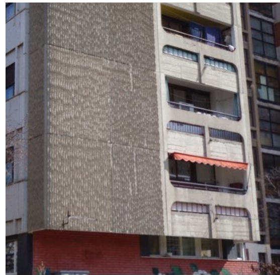
Слика 3-4. Бетонска платна на зградама новобеоградског блока 29 | Фото: Д. Игњатовић
