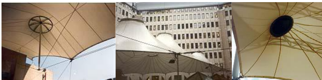
Слика 9 – карактеристични детаљи прстенова око тачке ослонаца шаторастог типа конструкције (извор: [3])
