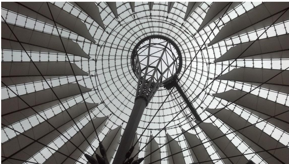
Слика 33а и б - пример примене DP: SONY CENTRE, Берлин Архитекта: Хелмут Јан, Инжењери: Ове Аруп и Партнери (извор:[9])
