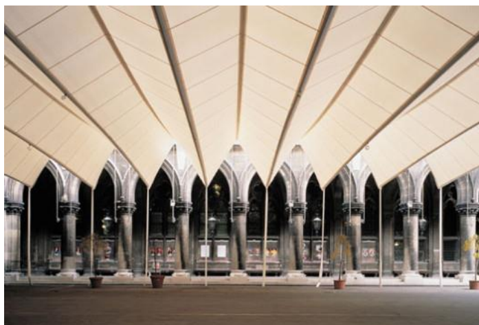
Слика 13 – покретна мембранска конструкција, атриум градске скупштине у Бечу, Аустрија (извор:[10])
