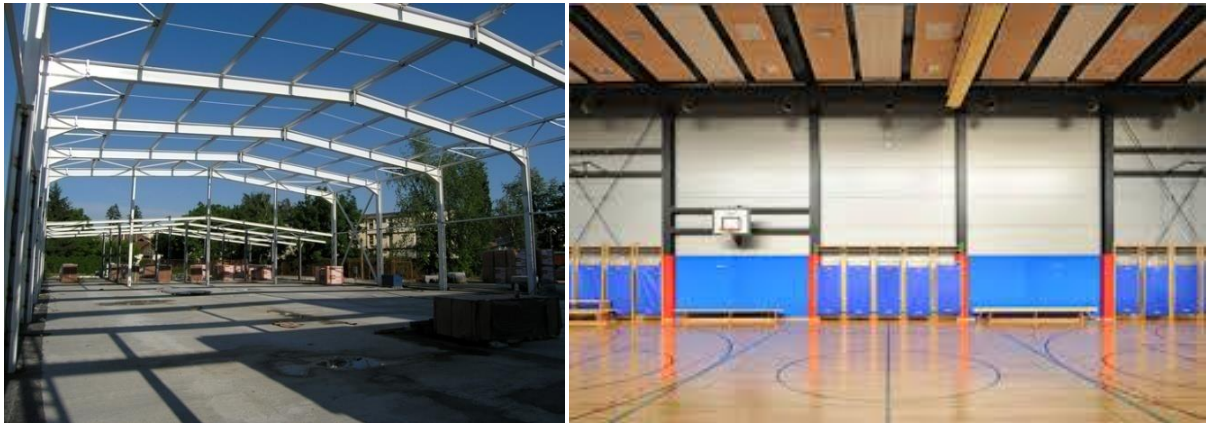
Слика 8. Изглед типичне челичне хале са сендвич панелима Извор: Unimont d.o.o – металне хале
