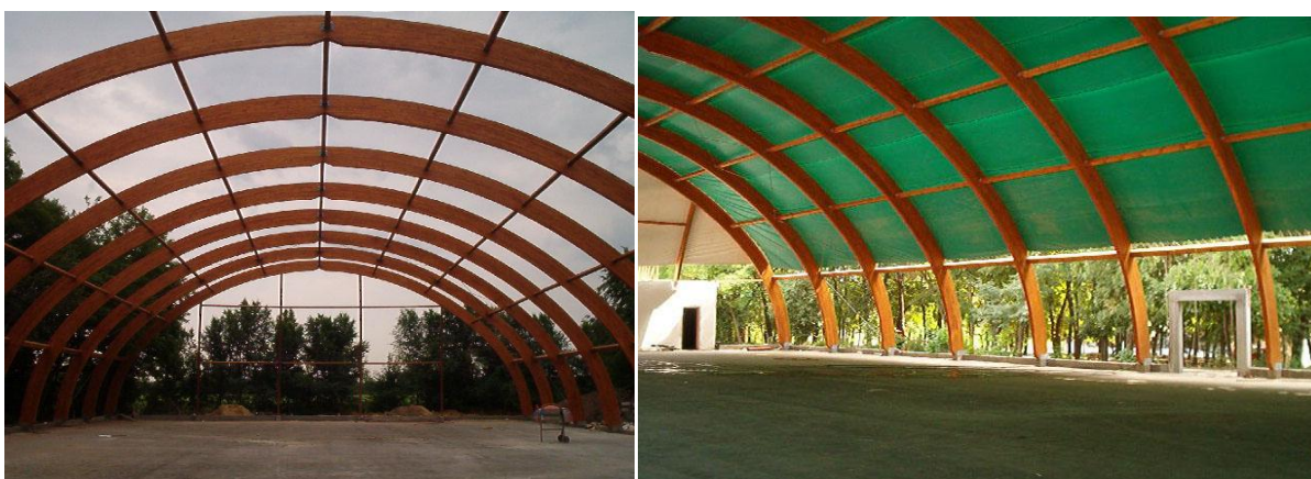
Слика 7. Изглед типичне балон хале с дрвеном конструкцијом
