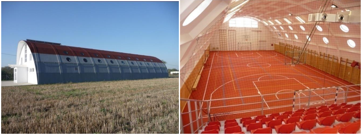
Слика 11. Изглед типичне префабриковане хале од фeroцементних сендвич елемената Извор: Milinkovic Company
