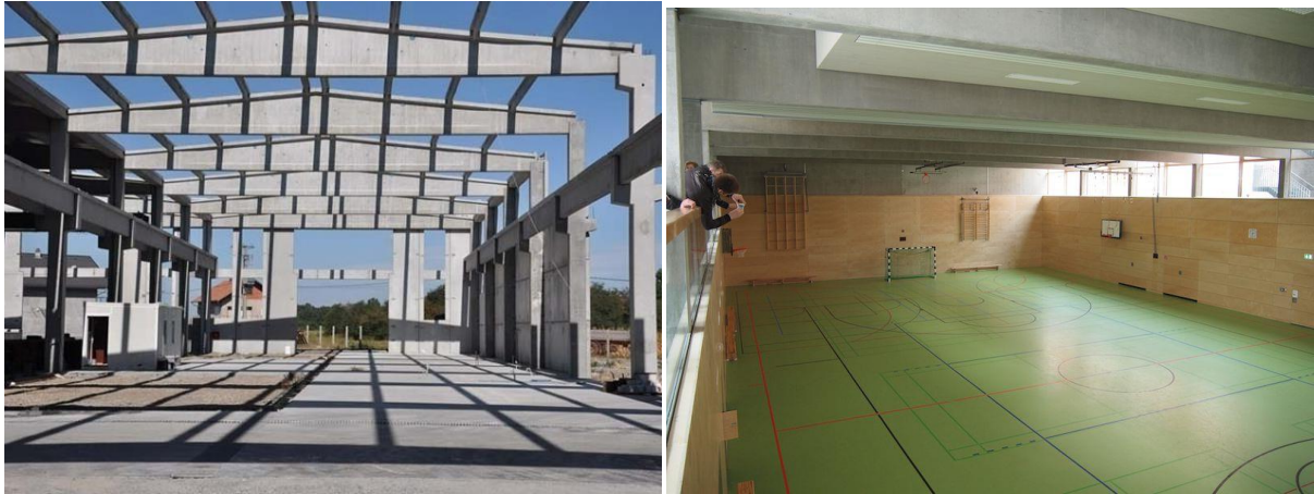
Слика 10. Изглед типичне хале од армирано-бетонских префабрикованих елемената
