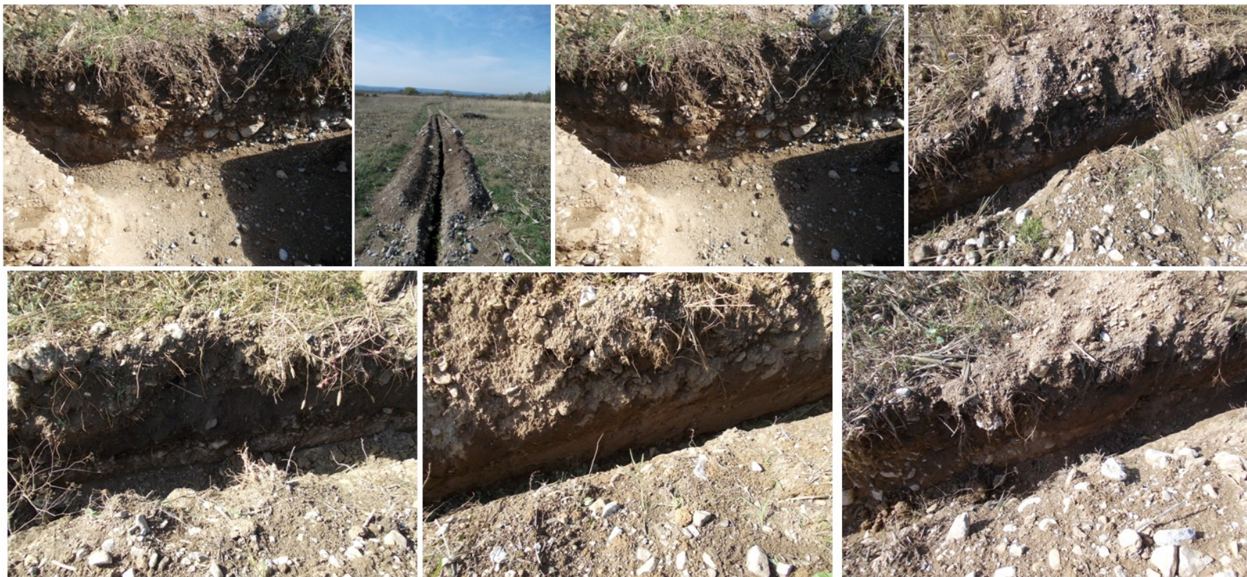
Сл. 9 Више фото-снимака рова за каблове отвореног од тока Решковачке реке па дужином од 100 m источном границом Великог поља, на коме се јасно уочава велико присуство скелета (веома крупног и ситног) у земљишту као и његово различито концентрисање по дубини рова без правилности у појављивању
