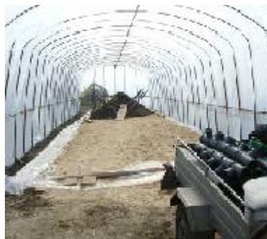
Slika 4.2. Postavljanje cevi za aeraciju
