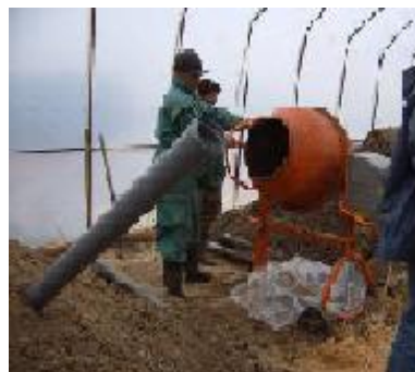
Slika 4.3. Mešanje zemlje pre nanošenja na haldu
