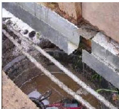
Slika 4.5. Sistem oluka za sakupljanje procedne tečnosti
