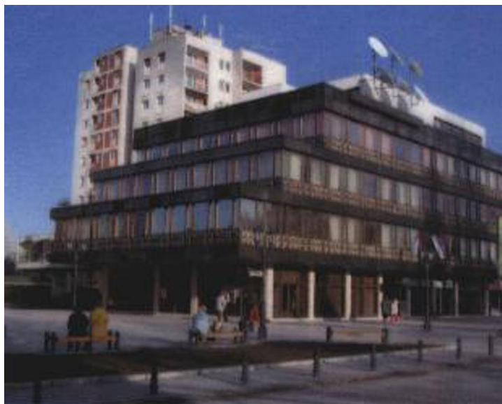
Slika 227. Zgrada Opštine Vrbas
