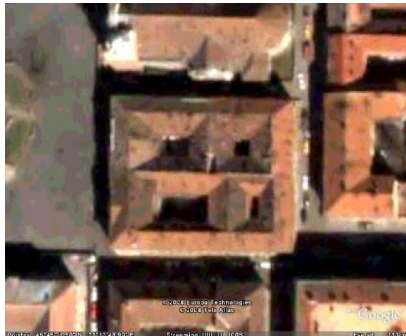
Pravougaoni oblik centralnog bloka u Temišvaru
