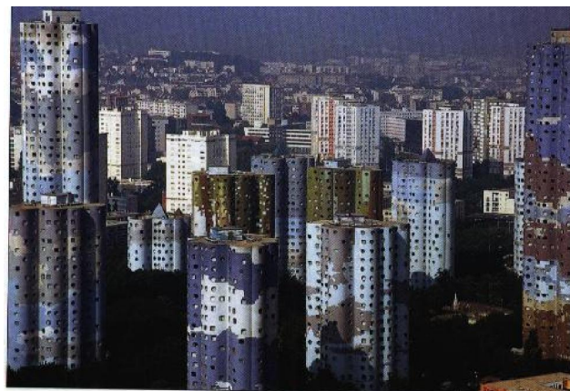
Slika 123. Izražena vertikalnost i šarenilo stambenih zgrada, Pariz, Francuska
