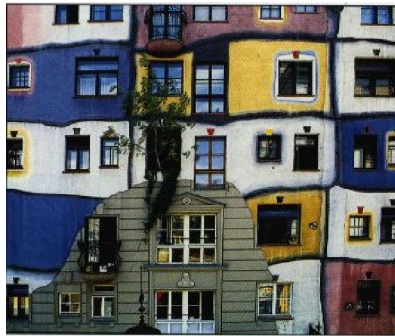
Deo fasade zgrade Hundertvasera u Beču, Austrija
