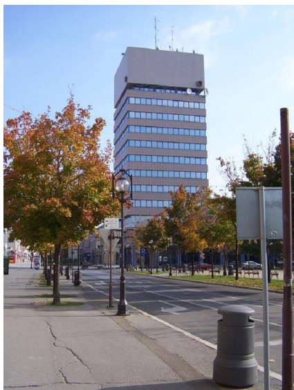
Slika 241. Zgrada vodotornja u bloku u centru Zrenjanina
