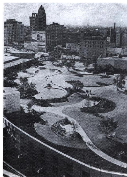
Slika 93. Zelena površina na krovu garaže, Okland, SAD
