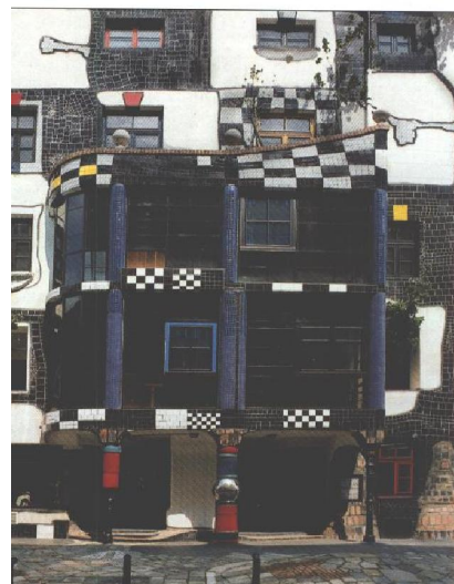
Slika 137. Umetnička obrada fasade, zgrada Hundertvasera u Beču, Austrija
