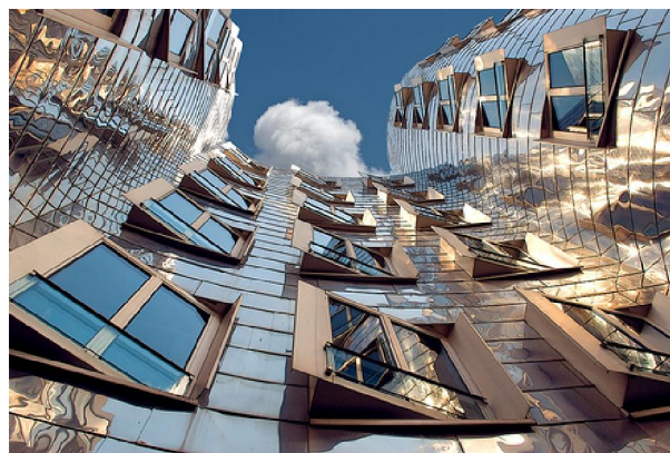
Slika 139. Plastika na fasadi, poslovni objekat u Dizeldorfu, Nemačka
