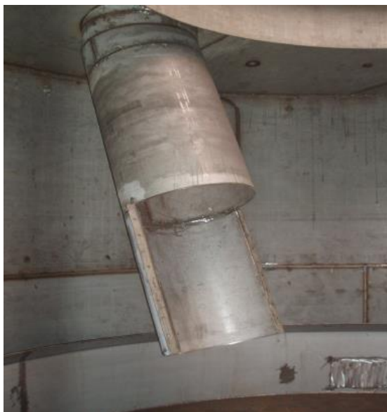
Slika 38. Ulazni levak kroz koji materijal ulazi u toster
