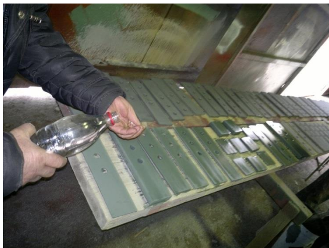
Slika 3.16: Prskanje filma svežom vodom u uslovima smanjene vlažnosti
