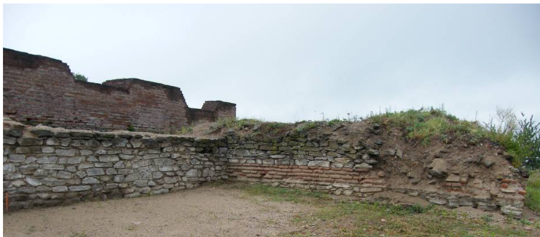
Слика 13: Југоисточна кула Акропоља: алтернација камена и опеке
