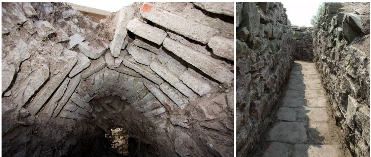
Слика 122: Конструкција над клоаком за одвођење вишка воде из писцине у атријуму Епископске базилике на Акропољу (лево) и под исте клоаке
