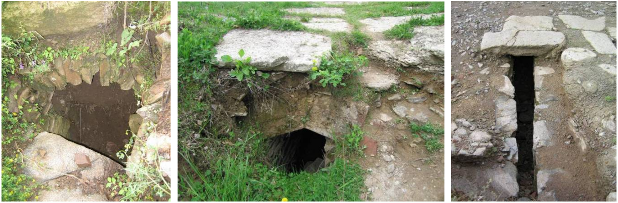
Слика 121: Део клоаке на Акропољу Царичиног Града (лево) иконструкција над клоаком која пролази испод Источне капије Доњег Града (средина) Клоака мање пропусне моћи у Доњем граду (десно)
