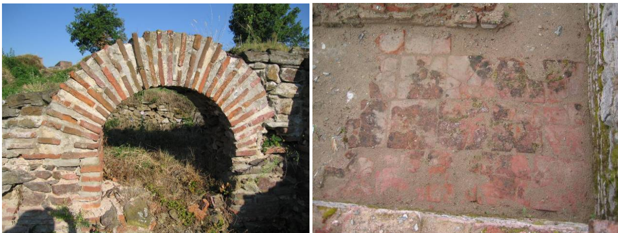
Слика 142: Примена опеке код израде лукова: Кућа са аркадама (лево) и детаљ поплочања опеком у југозападној кули Доњег града (десно)
