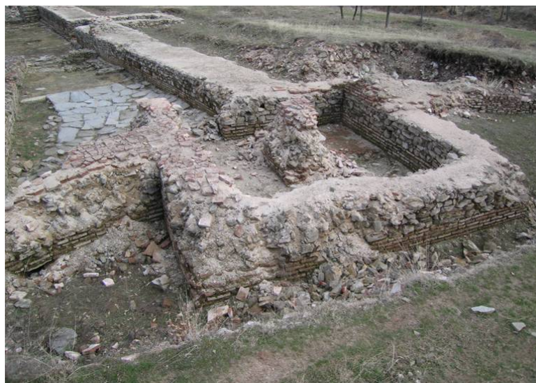
Слика 23: Југозападна угаона кула Доњег града
