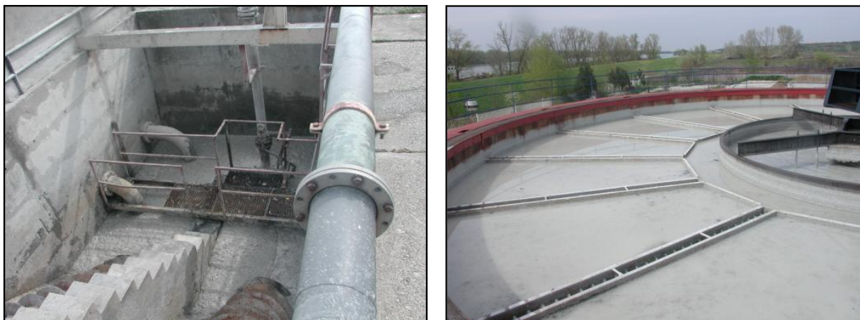
Slika III-12. Egalizacioni bazen za otpadne vode (a) i radijalni taložnik sa lamelarnim odvodima prečišćene vode (b)
