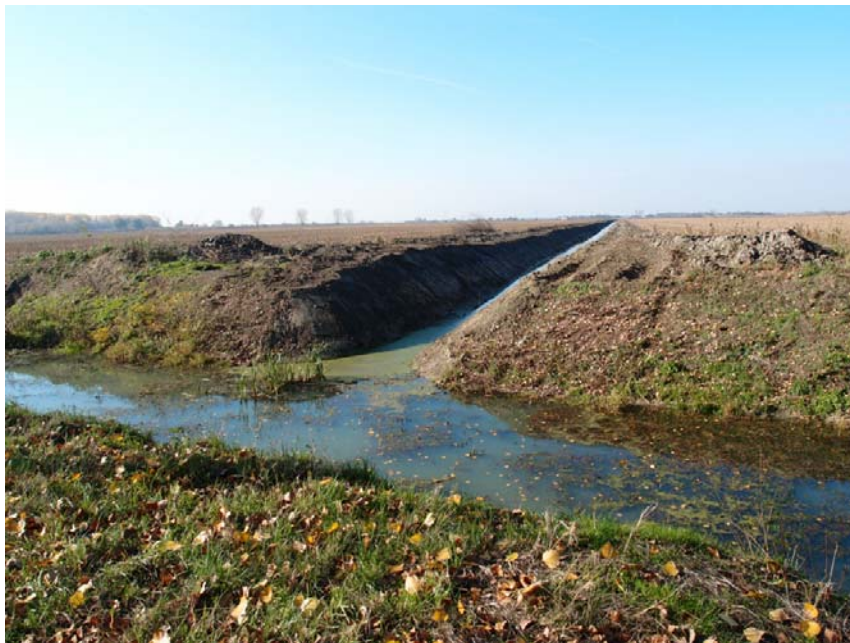
Слика 4.3.15: Очишћени дренажни канали у зони бунара Вр-24 и уливање латералног канала у главни дренажни канал I линије (фото: Мајкић 2012)
