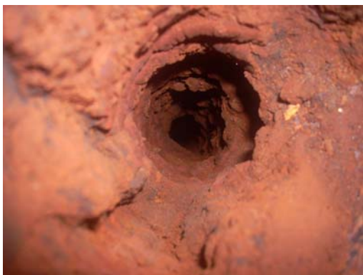
Слика 6.7: Талог у потисном цевоводу Вп-8а Трновче (фото: Миолски 2011.)
