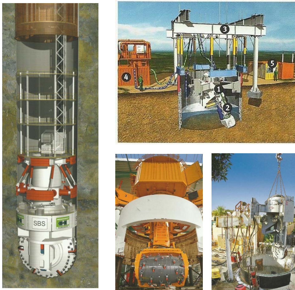
Slika 4-6, Ilustracije izrade okna VSM tehnologijom
