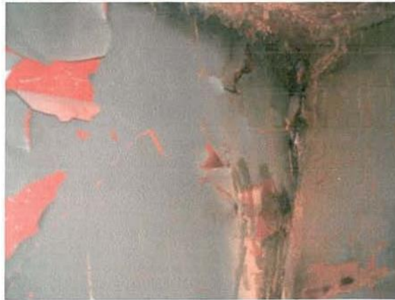
Слика 6.24 Прслина код ревизионог отвора [71]
