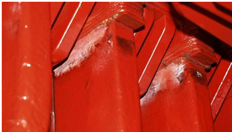
Slika 2.4 - Oštećena kanura usled mehaničkih oscilacija
