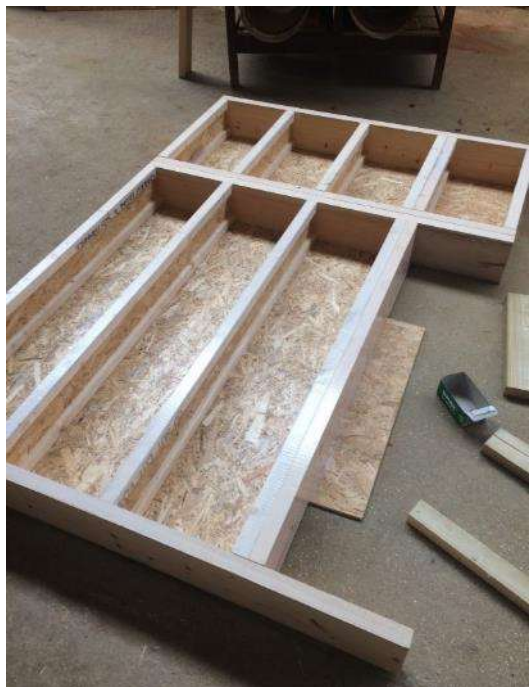
Слика 2.30. Производња префабрикованог панела (Practice Architecture 2019)
