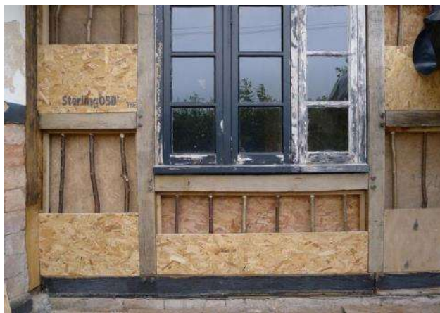
Слика 2.19: Припрема објекта са бондрук конструкцијом за рестаурацију са бетоном од конопље и креча (Stanwix 2013)
