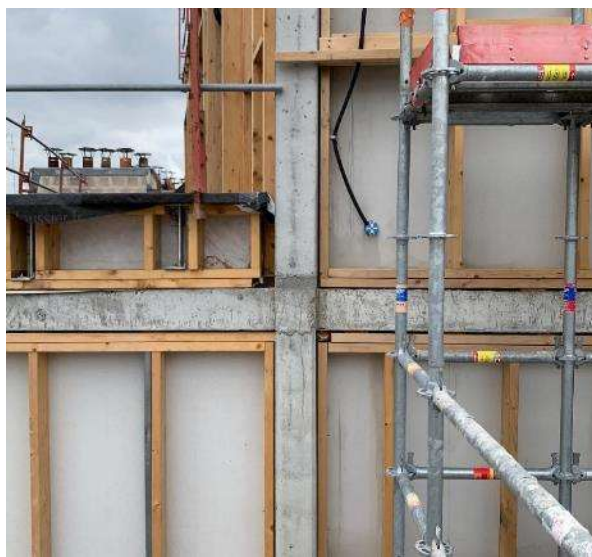
Слика 2.17: Бетонска конструкција са in situ бетоном од конопље и креча (Barrault Pressacco 2019)
