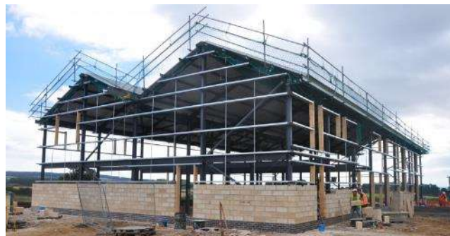
Слика 2.22: Зид од блокова од бетона од конопље и креча са челичном скелетном конструкцијом (UKHempcrete 2017)
