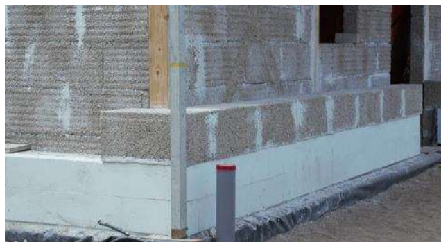
Слика 2.24: Два реда блокова од бетона од конопље и креча око дрвене конструкције (Isohemp 2018a)
