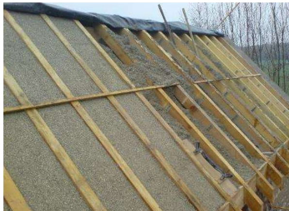
Слика 2.34. Коси кров са изолацијом од бетона од конопље и креча (Weber-Tradical n.d.b)
