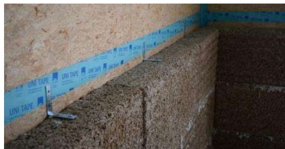
Слика 2.27: Блокови од бетона од конопље и креча постављени са унутрашње стране објекта (Isohemp 2018b)
