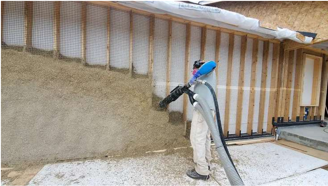
Слика 2.14: Прскање бетона од конопље и креча под притиском у полу затворену дрвену конструкцију (Hempitecture 2020)
