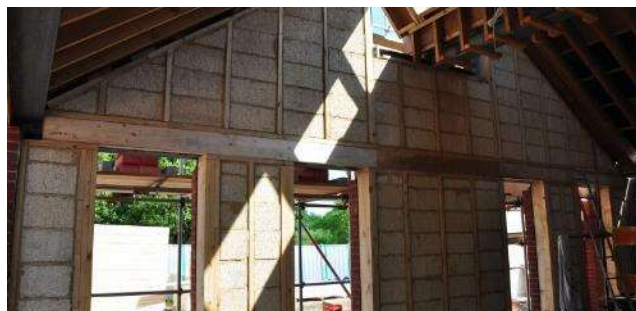
Слика 2.26: Блокови од бетона од конопље и креча између дрвене конструкције (UKHempcrete n.d.b)
