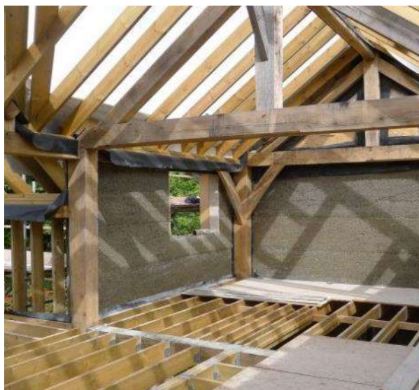
Слика 2.16: In situ зид од бетона од конопље и креча изграђен испред скелетне конструкције од храста (UKhempcrete 2013)
