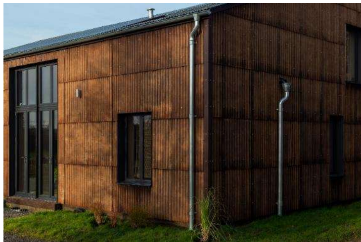
Слика 2.32. Фасадни панели од конопљиних влакана на Flat кући (Levy 2020)
