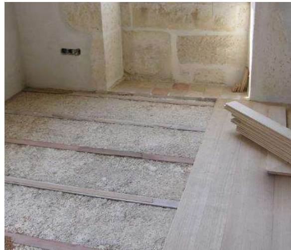
Слика 2.36. Под од бетона од конопље и креча (Weber-Tradical n.d.c)
