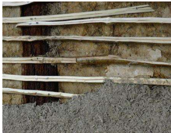
Слика 2.20: Примена бетона од конопље и креча преко чатме (Stanwix 2013)
