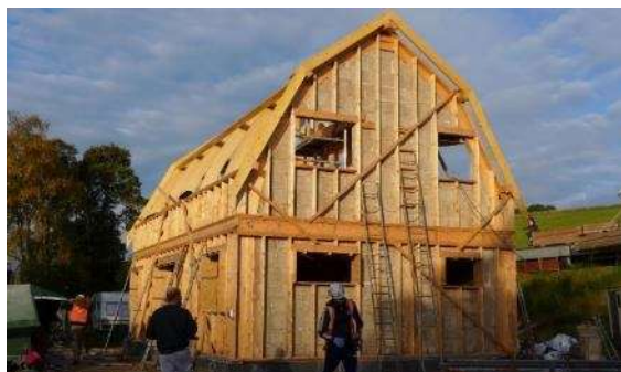
Слика 2.23: Конструкција од ламелираног дрвета са префабрикованим блоковима и in situ бетоном од конопље и креча (UKHempcrete n.d.a)
