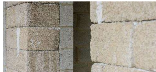
Слика 2.28: Блокови од бетона од конопље и креча као спољашња термоизолација зида од бетонских блокова (Isohemp 2016)
