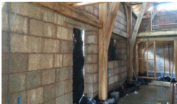
Слика 2.21: Зид од блокова од бетона од конопље и креча са скелетном конструкцијом од храста (Sparrow 2019)
