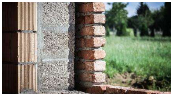
Слика 2.25: Блокови од бетона од конопље и креча у сендвич конструкцији (Isohemp 2015)
