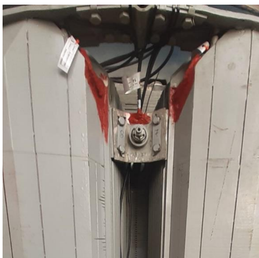
Слика 4.10: Приказ постављеног сензора за мерење температуре спољашње међуполне везе и гвожђа пола ротора хидрогенератора
