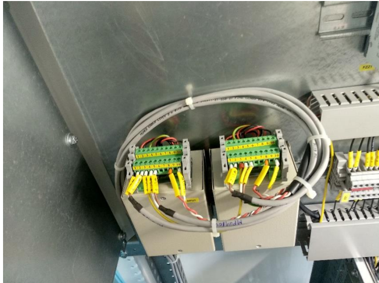
Слика 4.6: Уграђени мерни претварачи MPI и MPU
