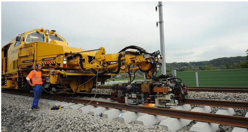
Slika 1.1 Mašina za automatsko elektrootporno zavarivanje šina u koloseku [1]
