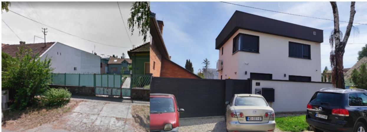
Слика 16. Изглед објекта С3 а) пре и б) после изградње.
