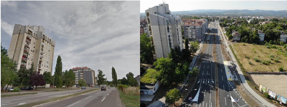
Слика 6. Изглед а) пре и б) после реконструкције пута на локацији С1.
