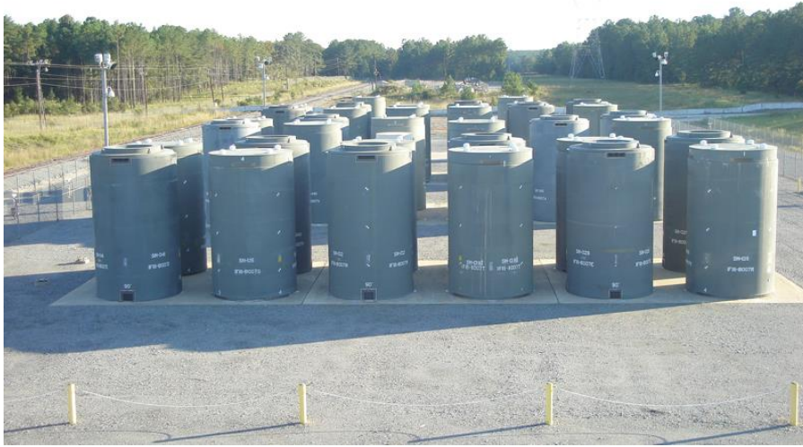
Слика 4.15. Складиштење исслуженог нуклеарног горива а) у базену и б) у сувом складишту.
