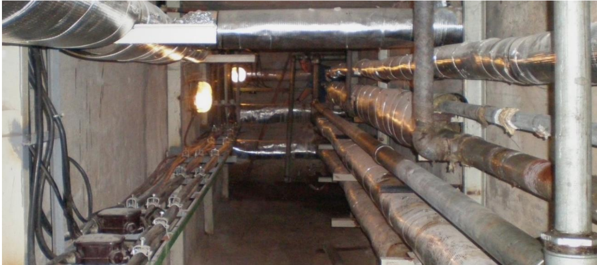
Слика 2.26 Пример водова смештених у подземни колектор
