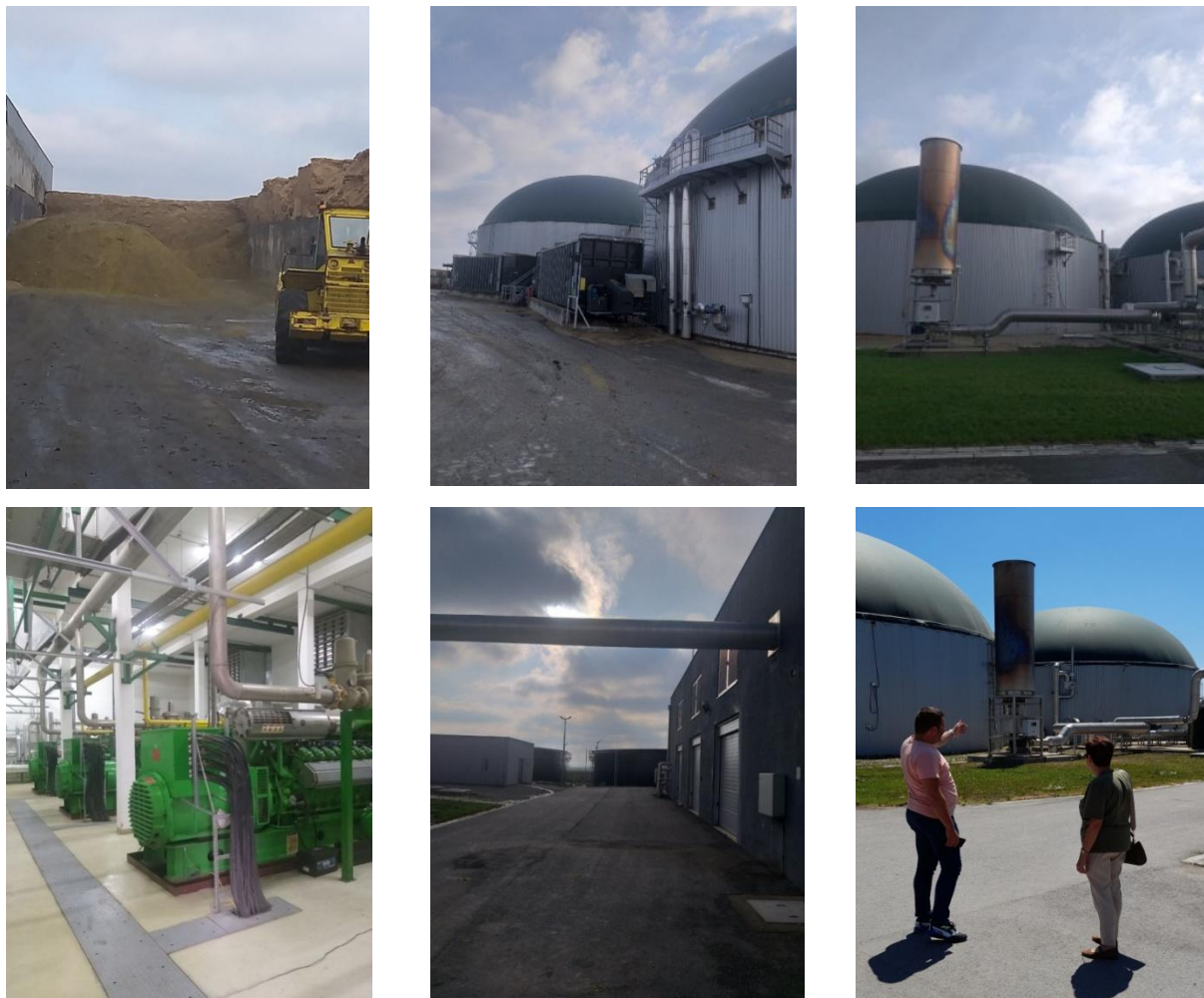
Slika 11. Komponente biogas elektrane: skladište silaže, transport sirovine, fermentor (gore), generatori električne energije, skladište digestata, sagorevanje viška biogasa (dole) (Foto Rakašćan, maj 2022)
