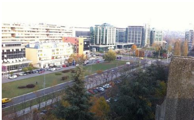
Слика 4.17 Део потеза Булевар Зорана Ђинђића планиран за изградњу лаког шинског метроа. Извор: архива ауторке.
