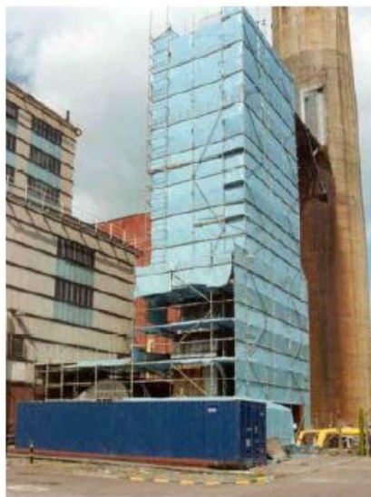
Slika 14: Struktura za ograđivanje pri uklanjanju azbesta (10)
