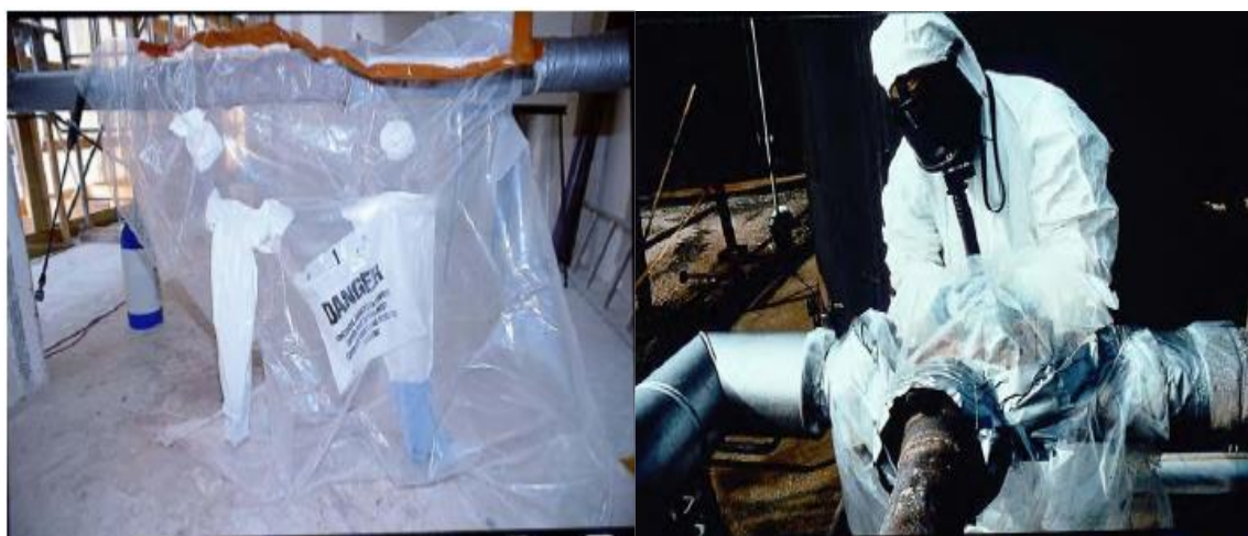
Slika 16: „Glovebags“ korišćeni za kontrolisano uklanjanje azbestne izolacije (10)
