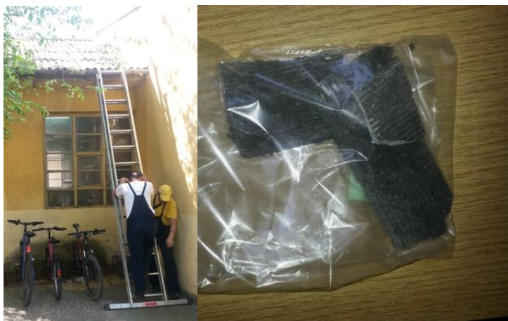
Slika 6 : Uzorkovanje azbesta za potrebe analize pre rušenja objekta TMD na Fakultetu tehničkih nauka
