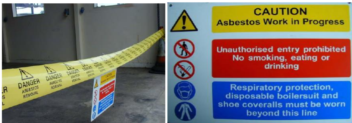
Slika 23: Primer upotrebe traka i znakova upozorenja da bi se izolovalo područje, koji simbolima i rečima ukazuju na opasnost i predostrožnost (10)
