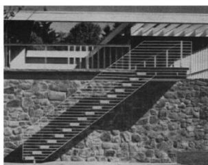
izgled baštenskog stepeništa
