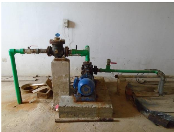
Slika 1.28 Sistem eksploatacije slanih mineralnih voda Slankamen Banje iz kopanog bunara „B-1” (SLanjača) (foto: M. Lazić, 2017) (Preuzeto od: B. Lazić, 2017)
