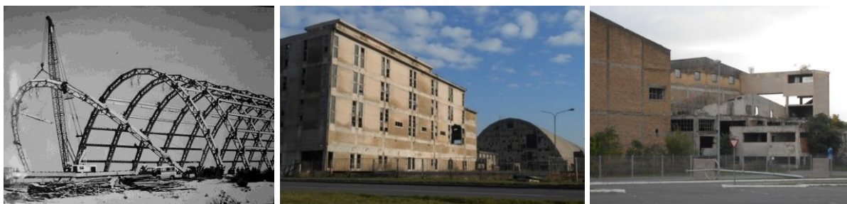
Slika 7.7: početak gradnje Agrohemu. Slike 7.8 i 7.9: devastirani i napušteni objekti fabričkog kompleksa.
