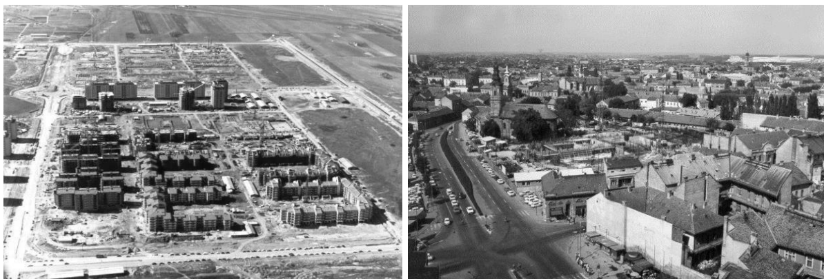
Slika 2.8: prva faza izgradnje Novog naselja. Slika 2.9: početak izgradnje Srpskog narodnog pozorišta.
