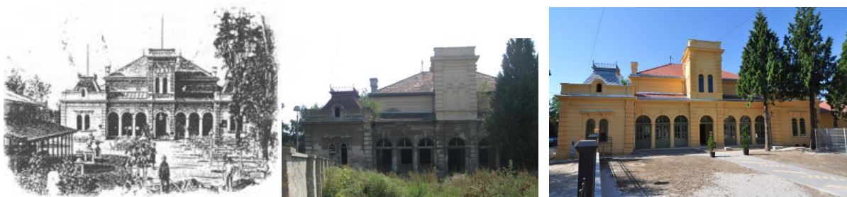
Slike 5.30, 5.31 i 5.32: Eđšeg – prvobitan izgled, stanje 2009. godine i nakon rekonstrukcije.
