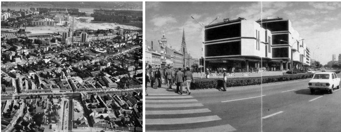
Slika 2.6: probijanje Bulevara 23. oktobra. Slika 2.7: robna kuća Stoteks kao simbol socijalističke potrošnje.
