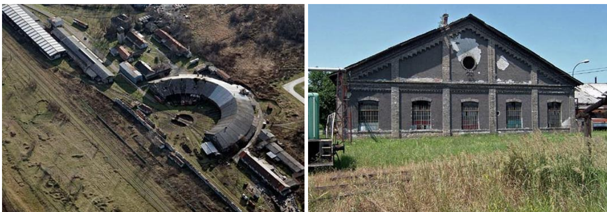
Slike 7.10 i 7.11: kompleks ranžirne stanice.
