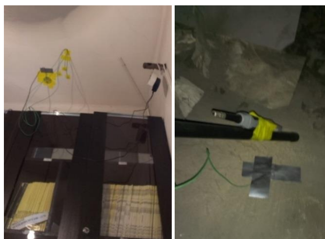
Слика 4.17 Приказ мерења топлотног флукса и температура за међуспратну конструкцију ка негрејаном таванском простору (слика лево - унутрашње мерење, слика десно - мерење на тавану)
