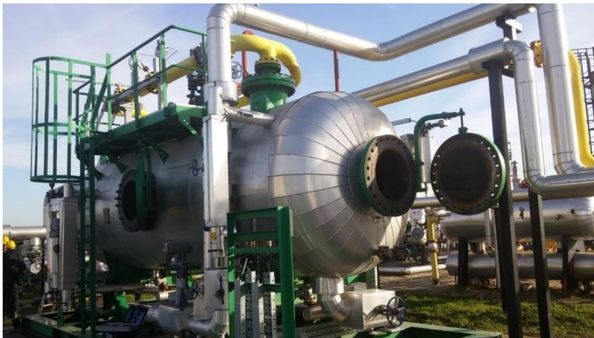
Slika 13. Horizontalni trofazni separator na naftnom polju
