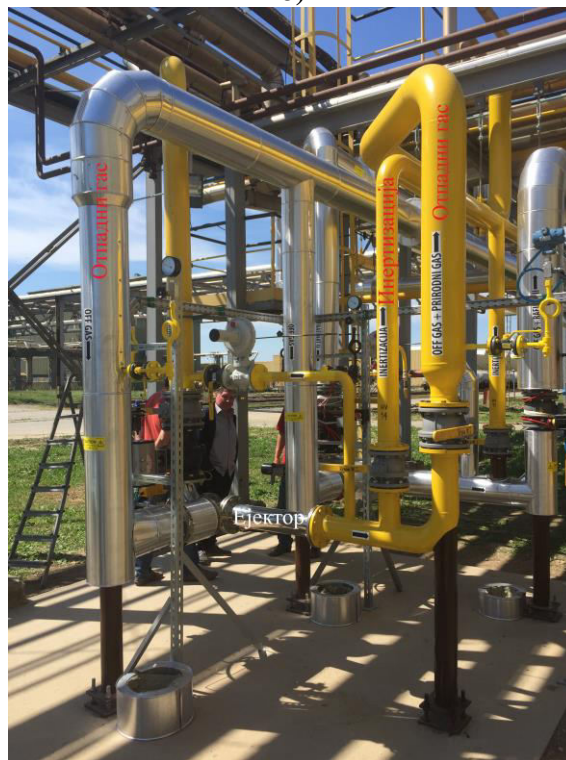
Слика 18 Фотографије индустријске инсталације коришћене при евалуација рада суперсоничног гасног ејектора са млазницом променљивог попречног пресека
