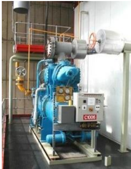
Slika 32. Kompresorska jedinica pivare “Karslberg” iz Northemptona [19]
